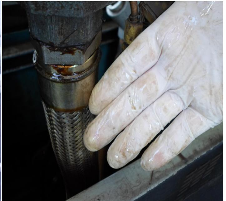
Foto 4. Unidade de abastecimento de Diesel com vazamento.
