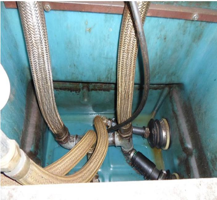
Foto 5. Câmara de contenção do Diesel sem manutenção adequada.
