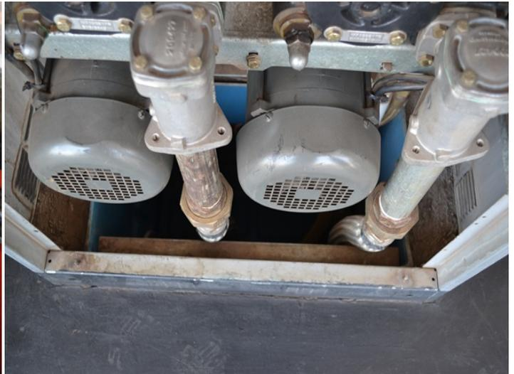
Foto 17. Detalhe da tubulação que não está totalmente contida pela câmara de contenção.
