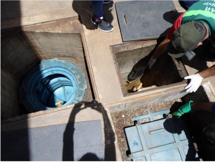
Foto 15. Visão das caixas de coleta de óleo e amostragem.
