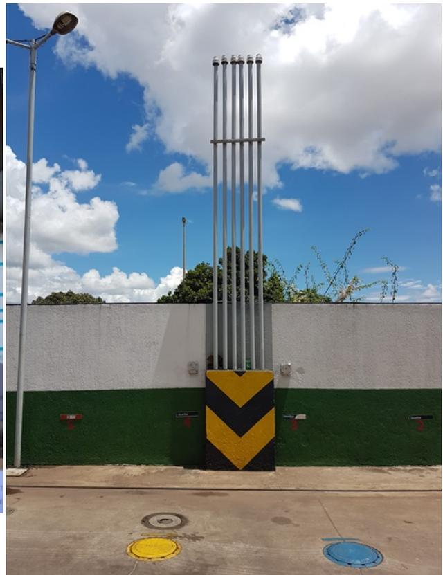
Foto 8. Respiros instalados na lateral do posto.
