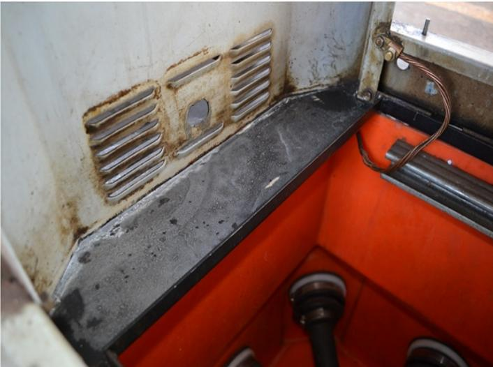
Foto 16. Detalhe do dispenser da câmara de contenção com aberturas na lateral.
