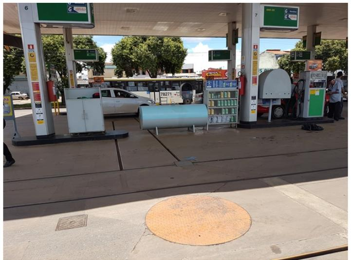
Foto 10. Tanque de armazenamento do OLUC localizado em local coberto e circundado por canaletes.
