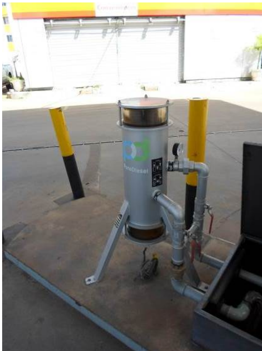
Figura 3. Aspecto do filtro de Diesel localizado na pista de abastecimento e circundado por canaletes.
