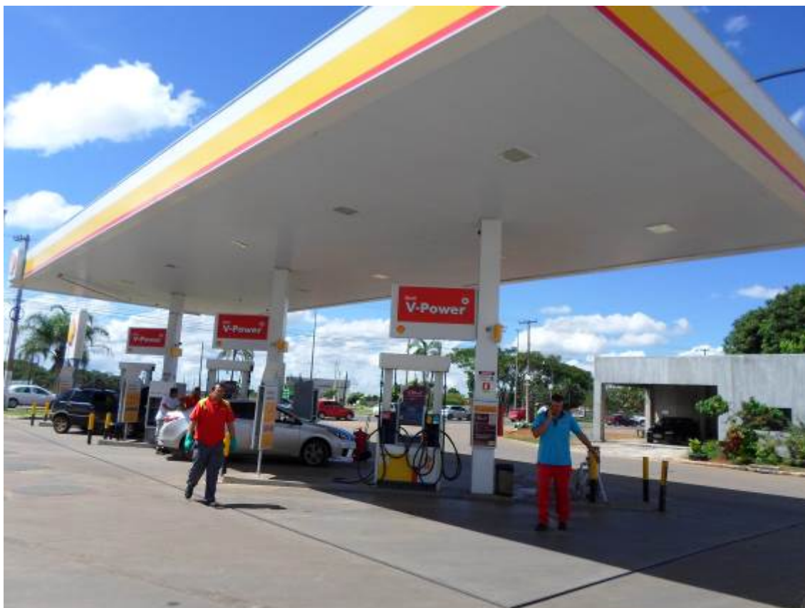
Figura 1. Aspecto geral do posto, pista de abastecimento e das unidades Abastecedoras.
