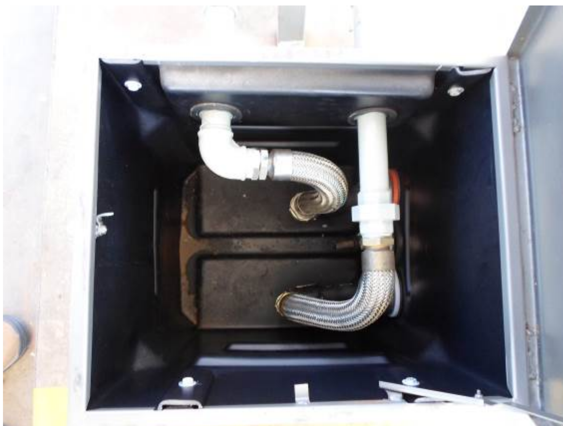
Figura 3. Aspecto do filtro de Diesel localizado na pista de abastecimento e circundado por canaletes.
