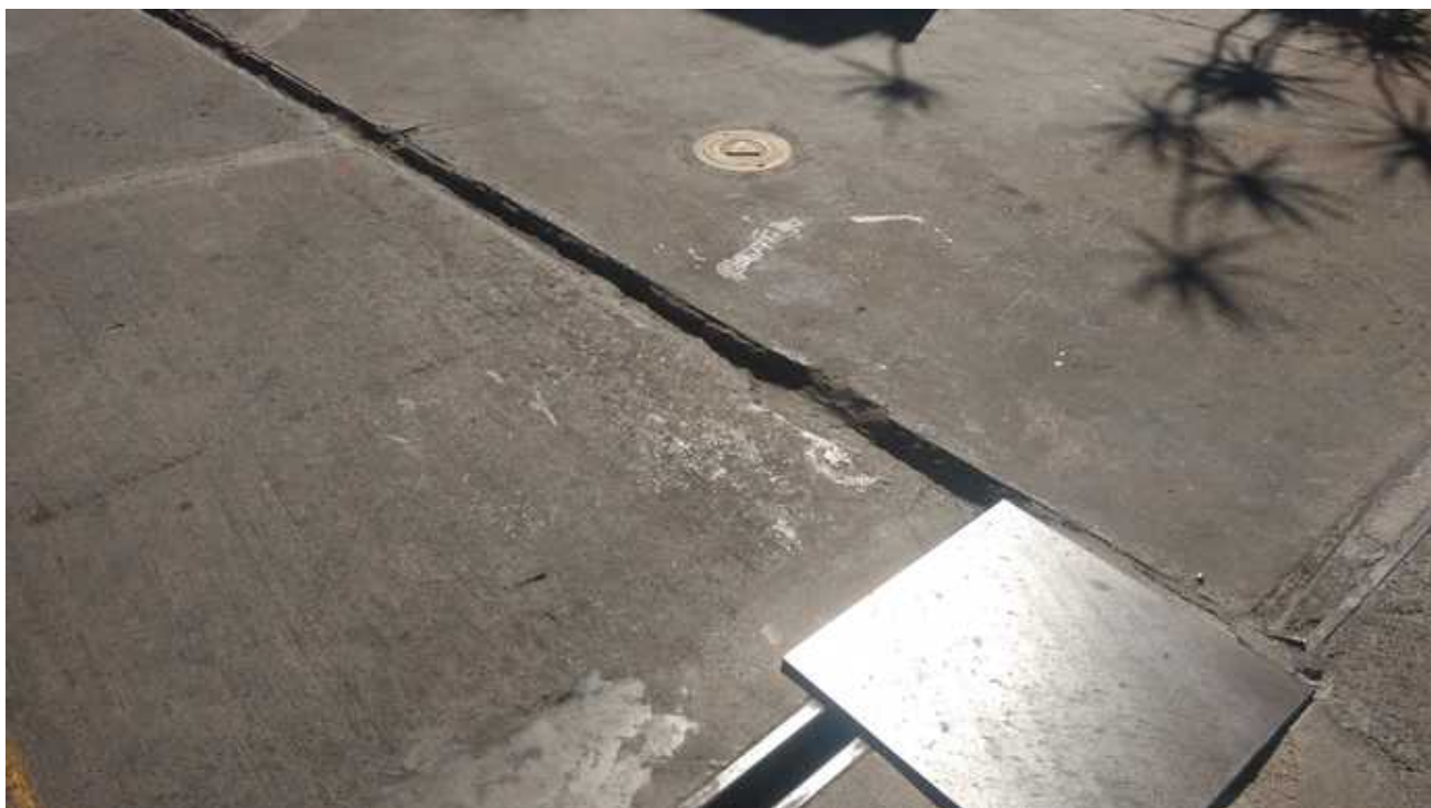
Figura 11 - Canaletes próximo a área dos tanques subterrâneos.
