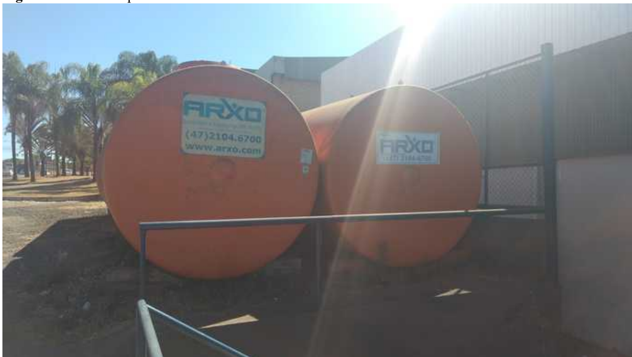
Figura 22 - Tanques subterrâneos aguardando instalação.
