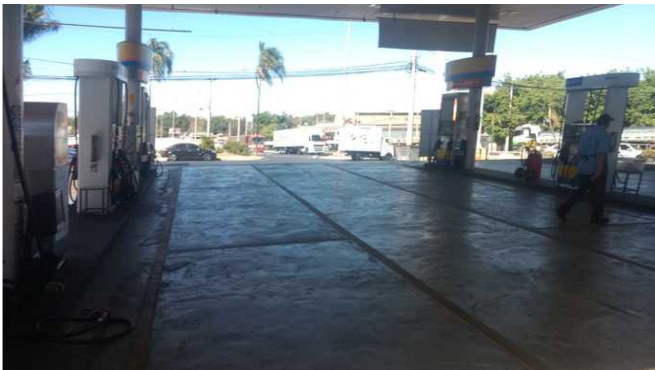
Figura 3 - Pista de Abastecimento (2).
