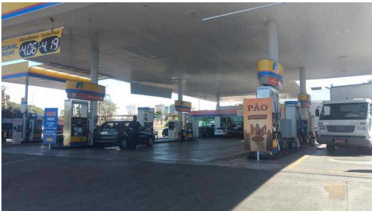
Figura 2 - Pista de Abastecimento.
