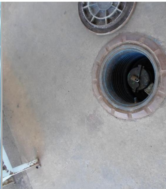
Figura 19 – Detalhe da Descarga Selada sob
