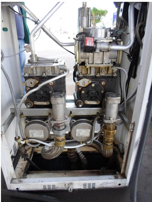
Figura 6 – Unidade abastecedora com sump e Check-valve.
