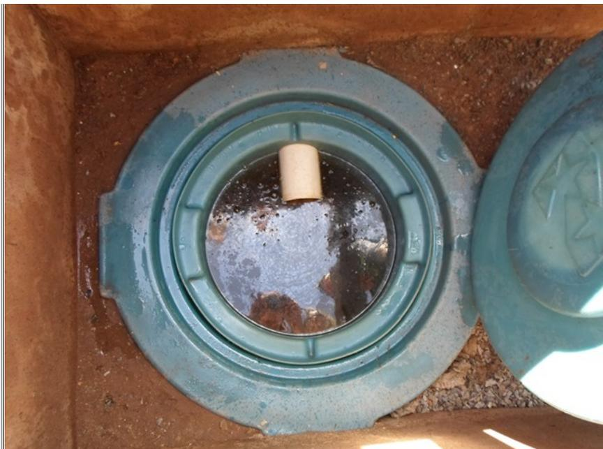
Figura 14 – Caixa Coletora do S.A.O. da pista de abastecimento.
