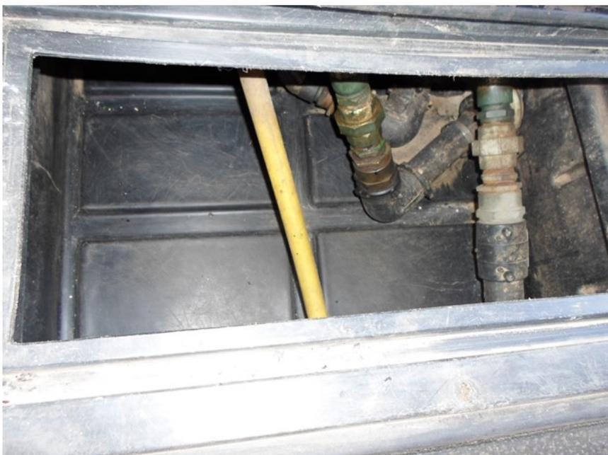
Figura 4 – Câmara de Contenção para Unidade de Filtragem localizada na pista de abastecimento.
