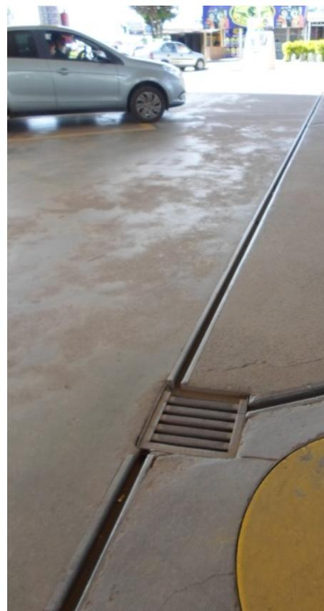
Figura 7 – Canaletes localizados na pista de abastecimento.
