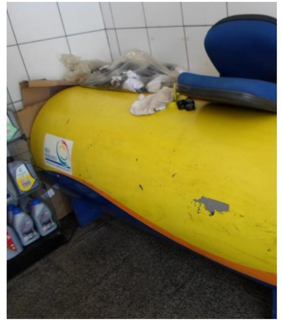
Figura 23 – Tanque aéreo de OLUC em local coberto e
