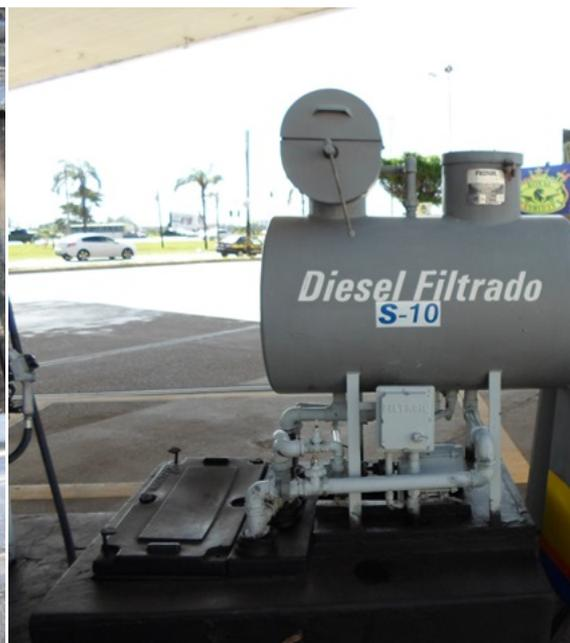
Figura 5 – Filtro de Diesel (S10) e câmara de contenção
