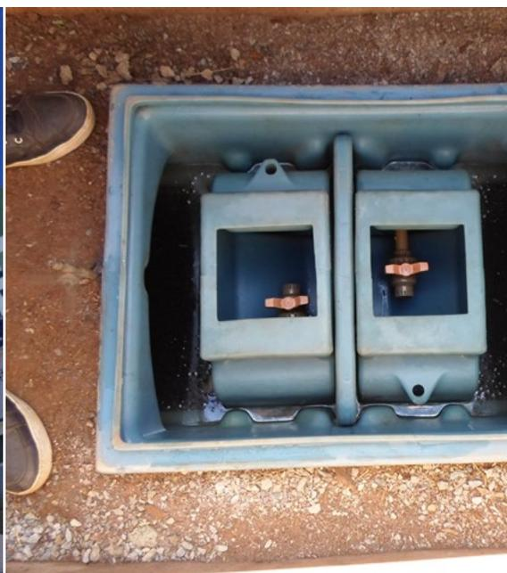
Figura 13 – Caixa Separadora do S.A.O. da pista de abastecimento
