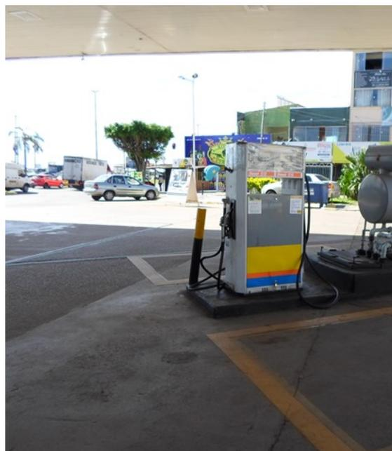
Figura 9 – Pista de abastecimento com bomba de combustível.
