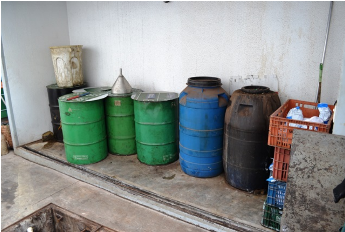
Figura 23 - Aspecto dos tambores para a segregação dos resíduos perigosos classe I. Observa-se que os mesmos estão localizados em uma área coberta com canaletes na parte frontal com fluxo para o SAO da pista de abastecimento, manutenção e lubrificação.
