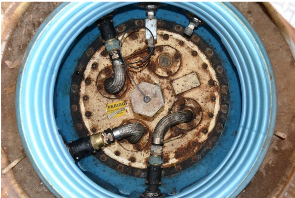
Figura 11 - Aspecto da Câmara de contenção ( sump ) na boca de visita do tanque com controle eletrônico de estoque, tubulação metálica flexível, tubulação subterrânea em PEAD e flanges de vedação. Observa-se a corrosão na tampa do tanque necessitando de manutenção operacional constante conforme exige a tabela 1 da ABNT NBR 15594-3:2008.
