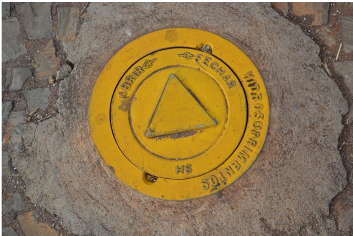
Figura 15 - Verificação do Monitoramento do Interstício de um dos 7 SASC.
