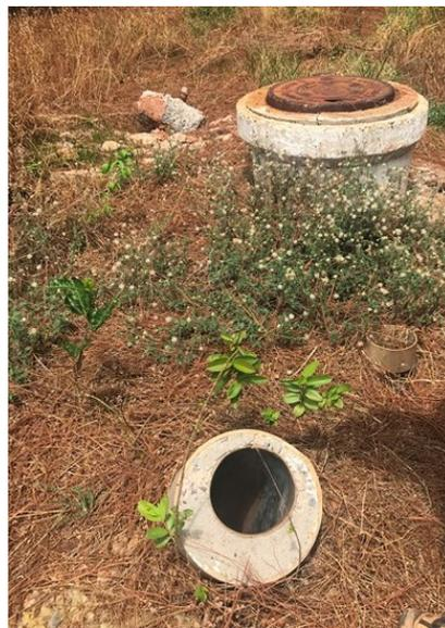
FOTO 14: PV de recepção dos esgotos dos condomínios (chegada á ETE Paranoá)
