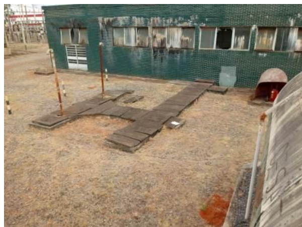
Figura 7: Local onde fica armazenado o tanque subterrâneo de armazenamento de combustíveis
