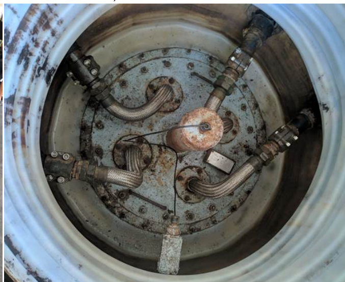
Foto 4. Detalhe da câmara de contenção do tanque.
