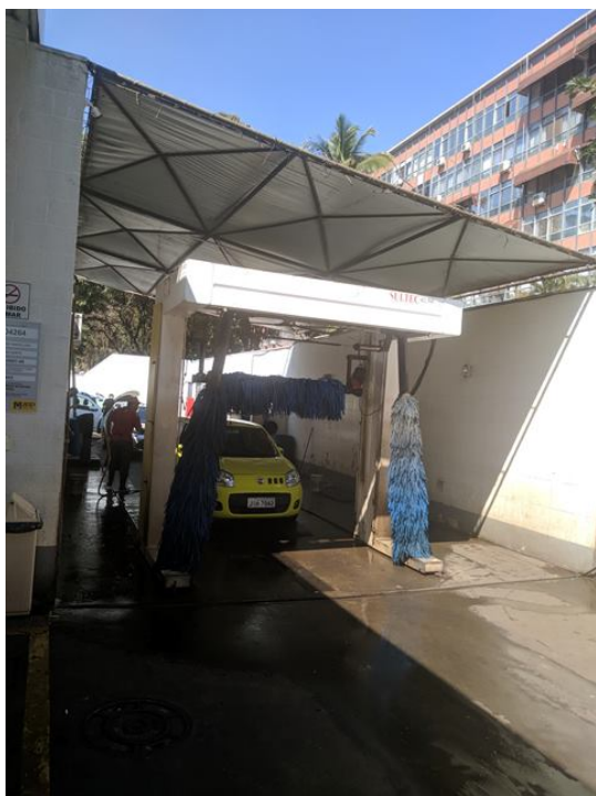
Foto 11. Visão geral da área de lavagem de veículos.
