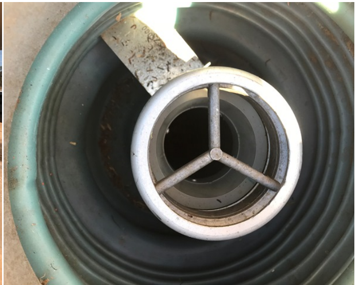
Foto 4. Câmera da descarga selada sobre o tanque.
