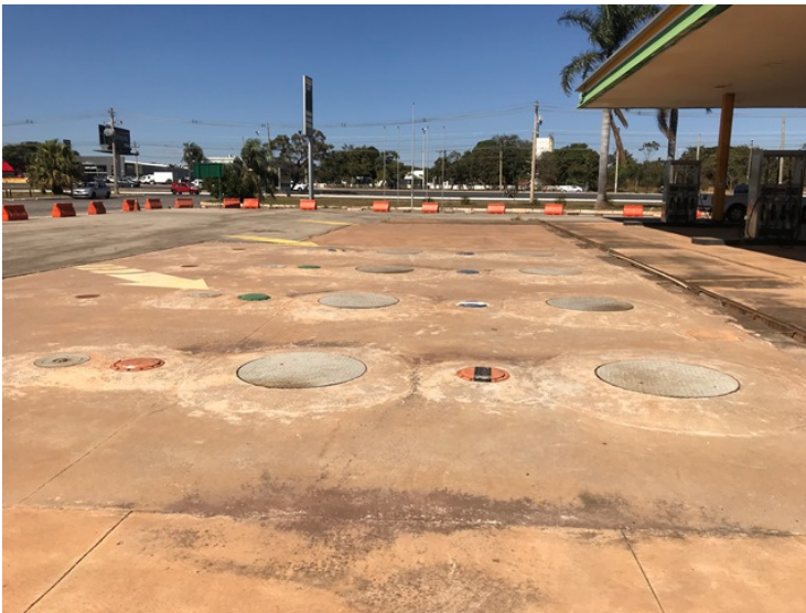
Foto 3. Visão geral dos tanques que serão retirados.
