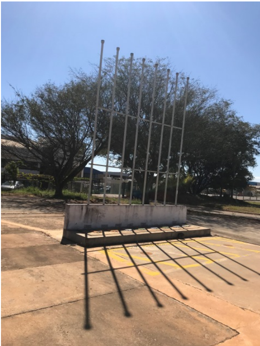
Foto 5. Visão geral dos respiros e da descarga selada à distância.
