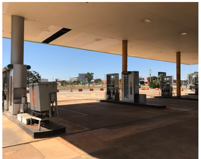
Foto 2. Visão geral da pista de abastecimento.
