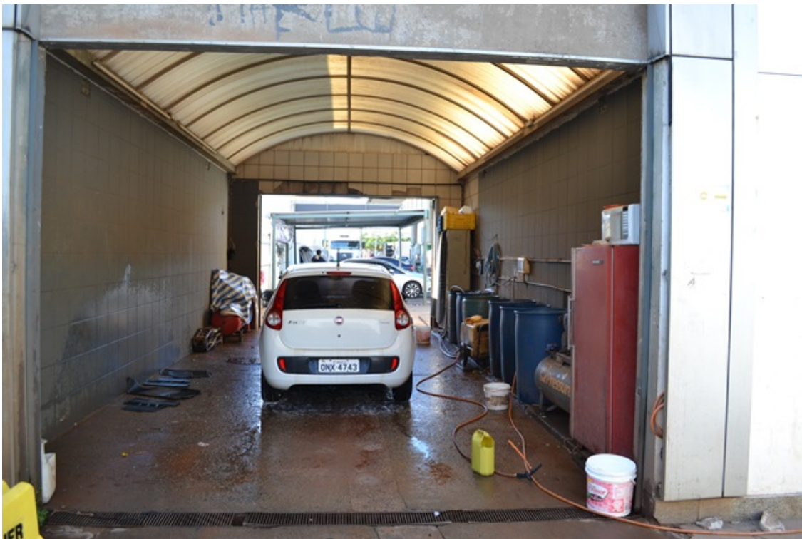
Foto 15: Área de lavagem de veículos contidas em canaletas e com caixa central.
