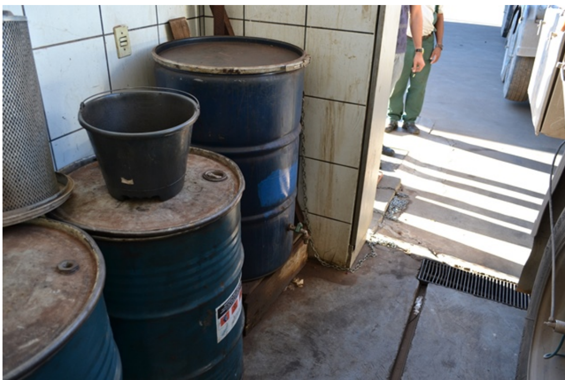
Foto 14: Área de lubrificação contendo barril de OLUC e barril de embalagens contaminadas. Nota-se que esta área está parcialmente contida entre canaletas.
