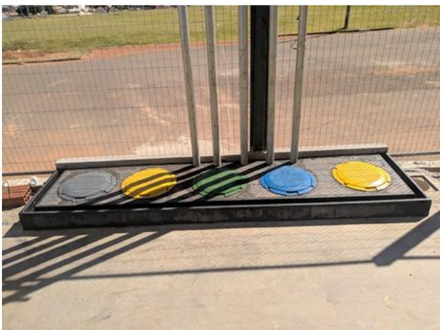
Foto 6: Descargas seladas à distância, circundadas por canaletos destinados ao SAO.
