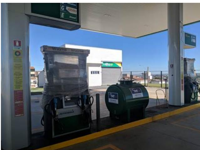
Foto 18: Tanque de OLUCA aéreo localizado na pista de abastecimento.
