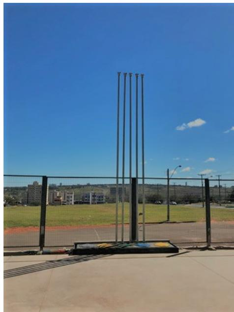
**Foto 21:** Respiros dos tanques, dotados de terminais corta-chamas.
