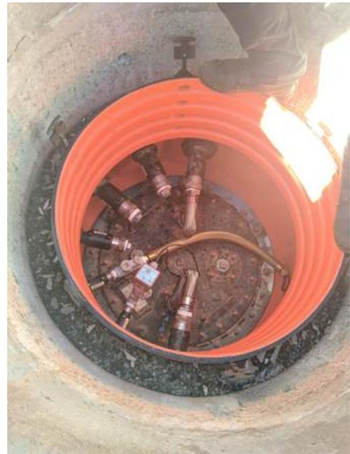
Foto 5: Acesso a boca de visita do tanque, com câmara de contenção.
