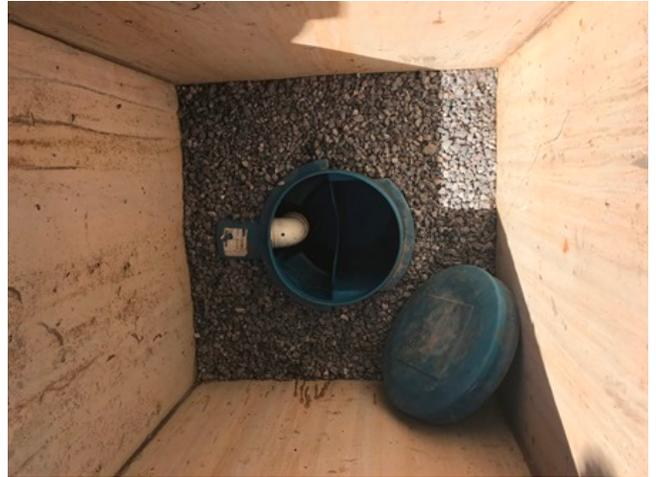
**Foto 11:** Módulo medidor de vazão com coleta de amostras Pista de Abastecimento.
