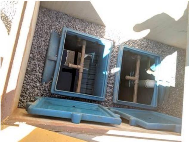
**Foto 10:** Caixa separadora de água e óleo - Pista de Abastecimento.
