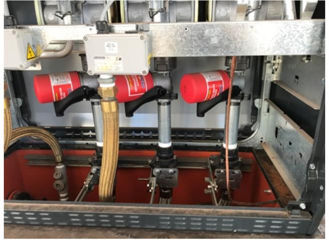
**Foto 9:** Câmara de contenção da unidade de abastecimento, observa-se que toda a tubulação que transporta combustível está contida dentro dos limites da câmara, *check valve* e boa manutenção do equipamento.
