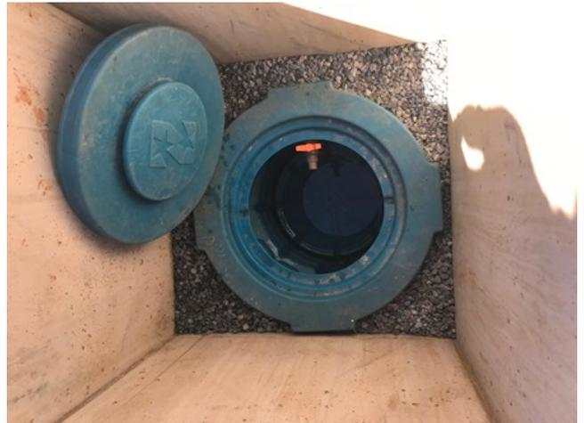
**Foto 13:** Caixa coletora de óleo da pista de abastecimento.
