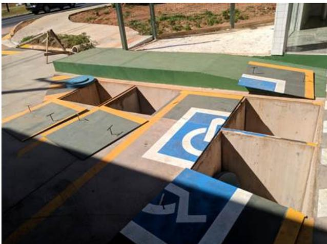
Foto 14: Sistema Separador de Água e Óleo - SAO da pista de abastecimento.
