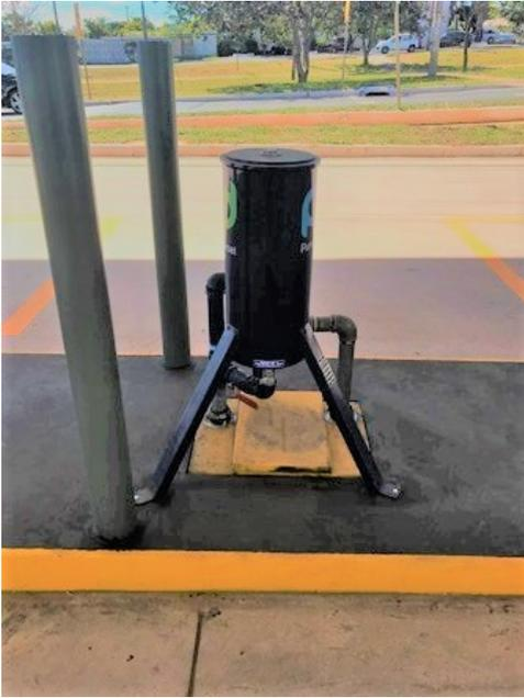
**Foto 8:** Unidade de filtro de diesel, dentro da pista de abastecimento com boa manutenção.
