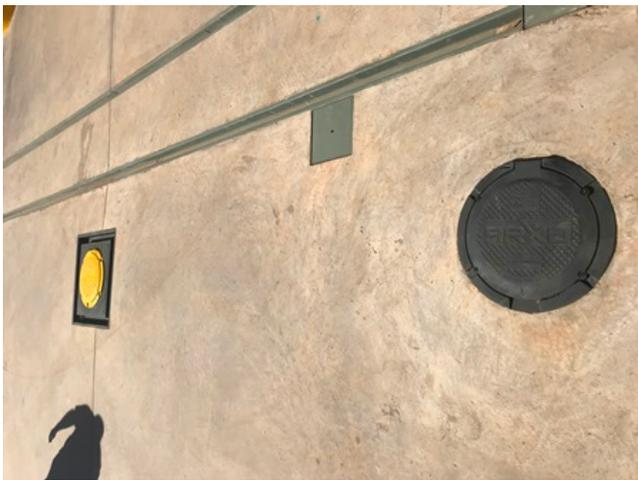
Foto 4: Descarga selada sobre o tanque com canaletos circundando a área.
