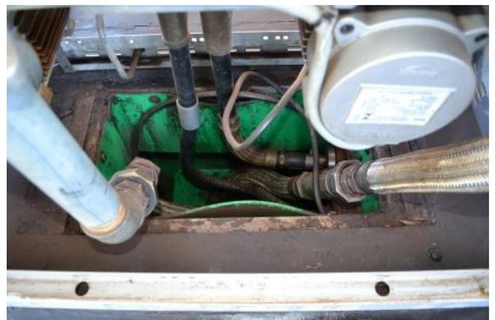
**Foto 11** – Unidade abastecedora com *sump* e *Check-valve* , evidenciando a tubulação fora da projeção.
