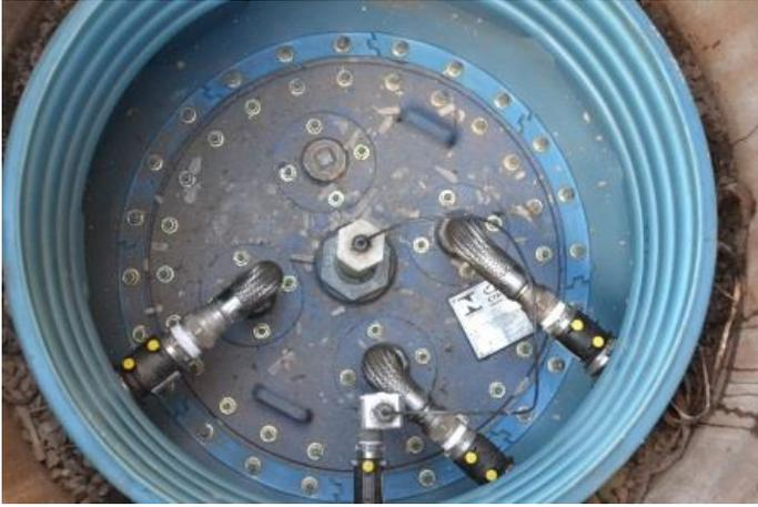
Foto 33 – Boca de Visita do Tanque evidenciando controle eletrônico de estoque e tubulação subterrânea de PEAD
