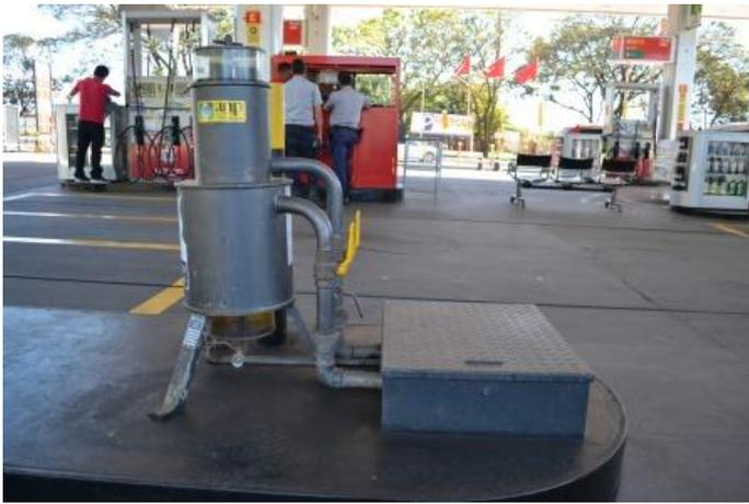
**Foto 6** – Filtro de Diesel (S10) e câmara de contenção da unidade filtrante.
