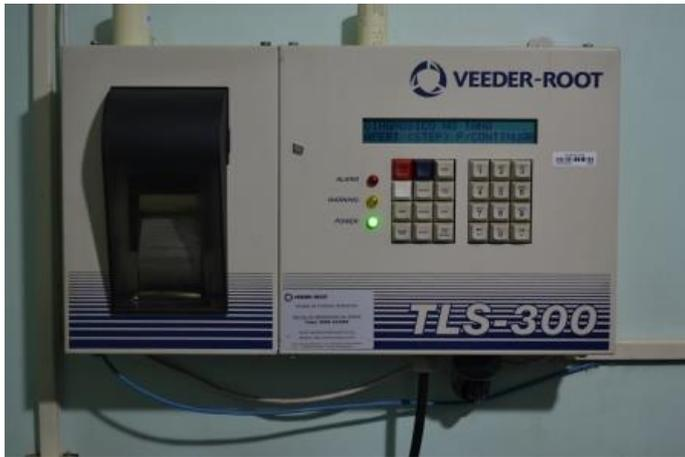
Foto 35 – Sistema de Monitoramento Ambiental e Controle de Estoque
