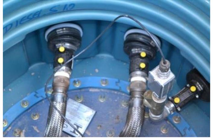
Foto 34 – Boca de Visita do Tanque evidenciando controle eletrônico de estoque e tubulação subterrânea de PEAD
