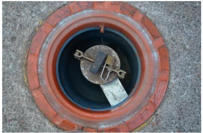
Foto 38 – Detalhe da Descarga Selada sobre o Tanque.
