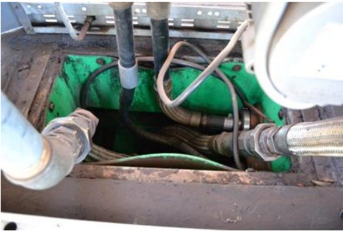
**Foto 12** – Detalhe da Unidade abastecedora com *sump* e *Check-valve*, evidenciando a tubulação fora da projeção.
