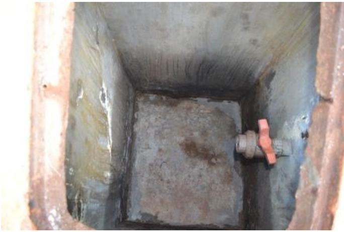
Foto 27 – Caixa Coletora de Óleo da pista de abastecimento.
