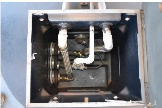
**Foto 10** – Câmara de contenção do filtro de diesel, com manutenção adequada.
