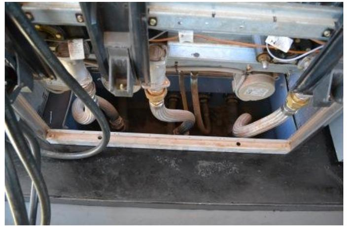
**Foto 7** – Câmara de Contenção para Unidade de Filtragem, localizada na pista de abastecimento.
