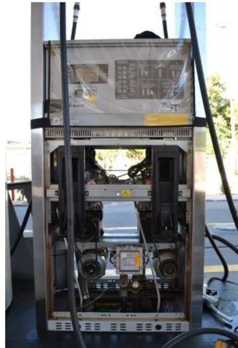
**Foto 9** – Unidade abastecedora com *sump* e *Check-valve*
