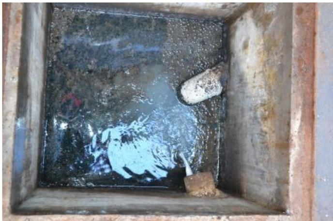
**Foto 25** – Detalhe da Caixa de Areia do SAO da Pista de Abastecimento.
