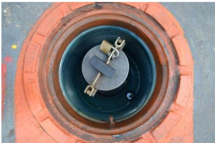
Foto 18 - Detalhe das descargas Seladas à distância, sem manutenção adequada.
