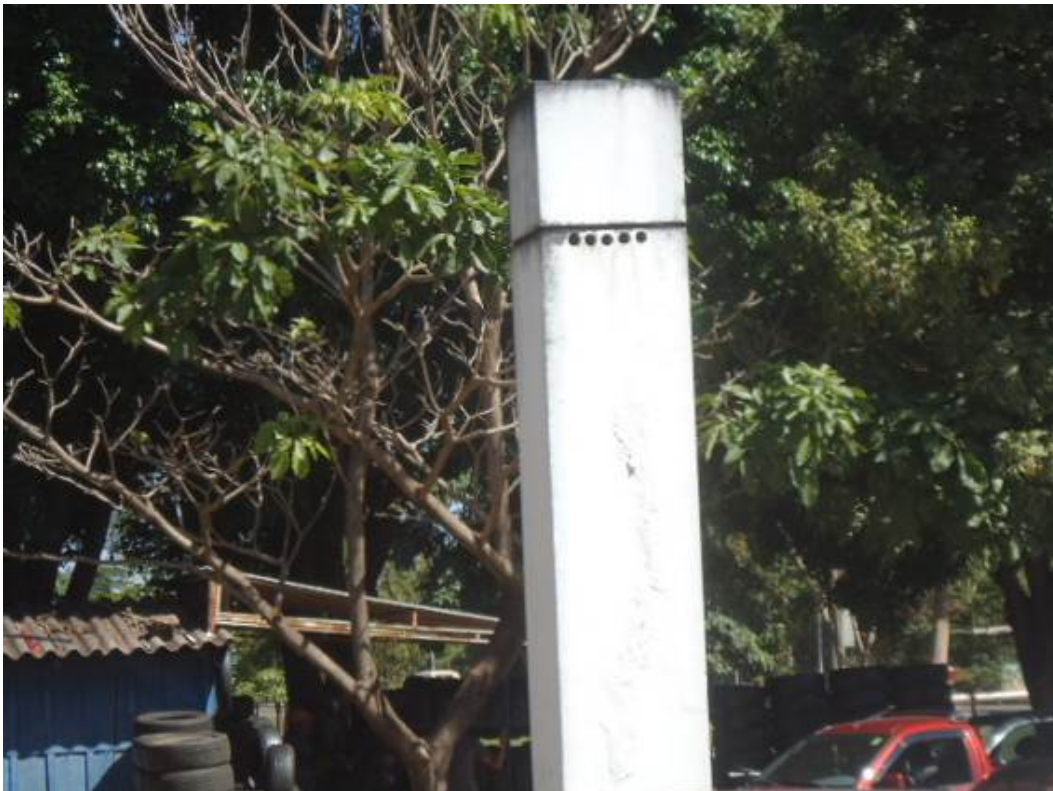
Figura 8 - Respiros dos tanques.
