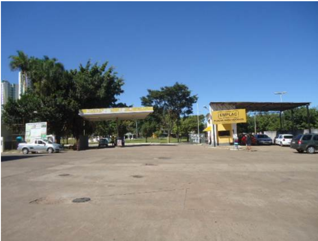
Figura 3 - Área de tancagem, com as bocas de vista dos tanques obstruídas pelo cimento.
