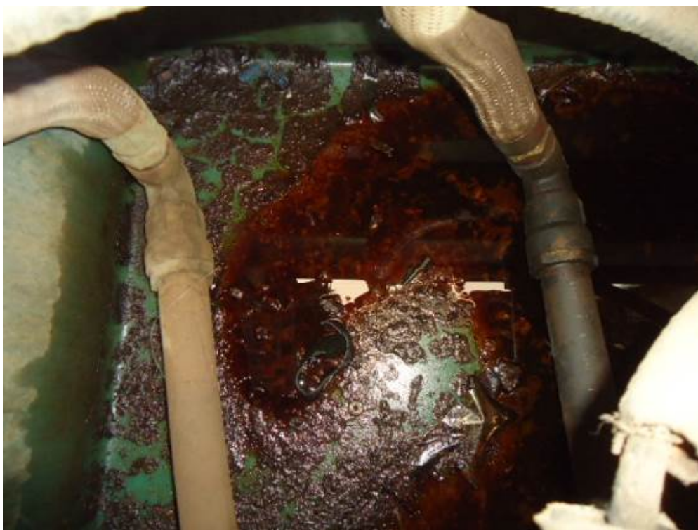
Figura 10 - Câmara de contenção da unidade de filtragem de diesel, evidenciando o vazamento de diesel.
