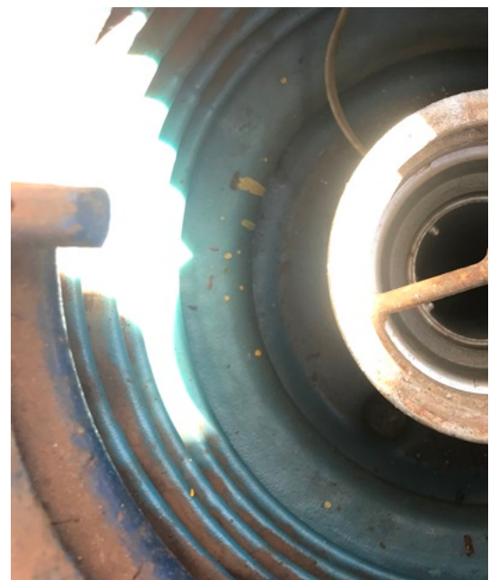
Foto 3. Detalhe da câmara de contenção
