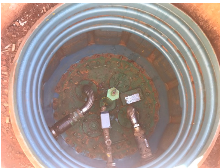
Foto 2. Visão geral da câmara de contenção do tanque.
