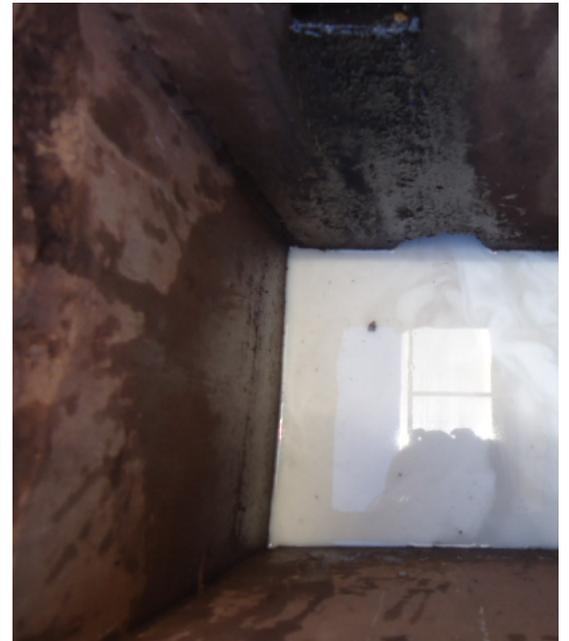
**Foto 49:** Detalhe do SAO da pista de abastecimento, área de lubrificação de veículos e área de descarga à distância.**Foto 50:** Detalhe da caixa de areia em concreto do SAO da pista de abastecimento e área de descarga à distância.
