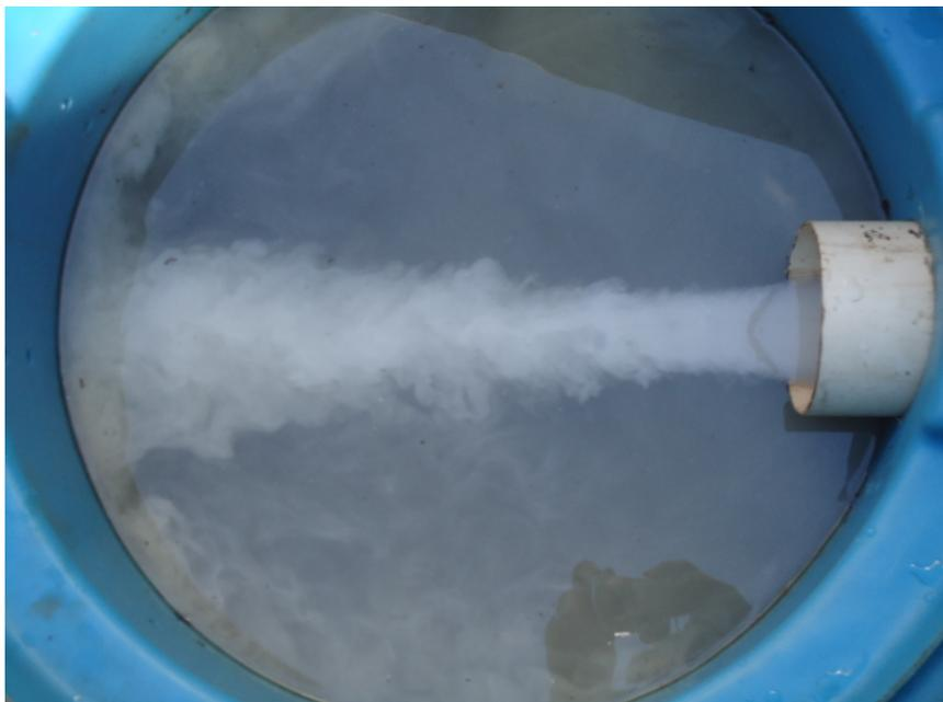
Foto 51: Caixa de areia em pré-moldado do SAO da pista de abastecimento em funcionamento.
