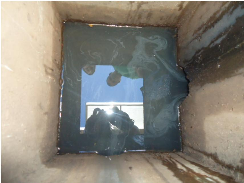
**Foto 41:** Caixa de areia em concreto do SAO da pista de abastecimento, área de lubrificação de veículos e área de descarga à distância.
