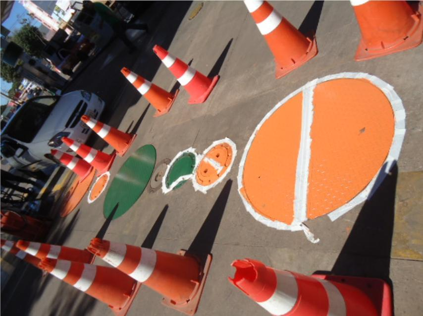
Foto 14: Localização dos tanques subterrâneos de armazenamento de combustíveis – Tanque Tripartido.
