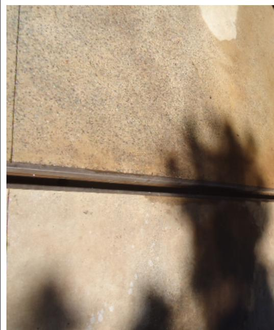
**Foto 35:** Área de lavagem de veículos com piso impermeável em bom estado de conservação, com cobertura e barreias e canaletes circundando a área.
