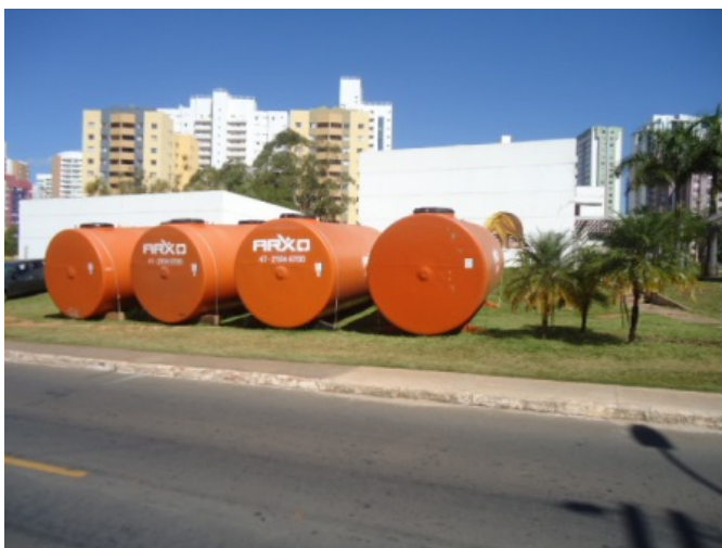
Foto 24: Tanques localizados na área externa do posto para substituição.
