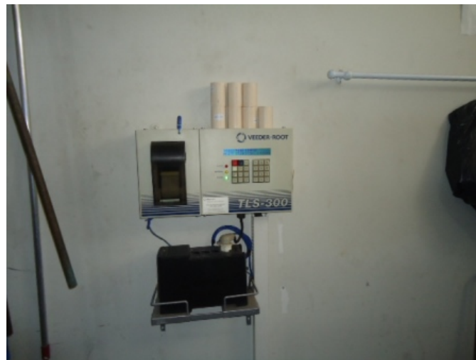
Foto 23: Monitoramento eletrônico de estoque Veeder Root.
