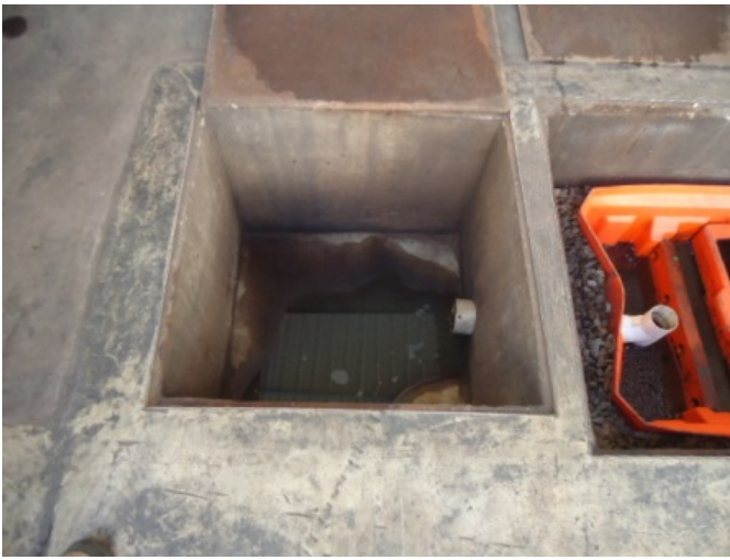
Foto 16: Caixa de Amostragem da área de lavagem de veículos.
