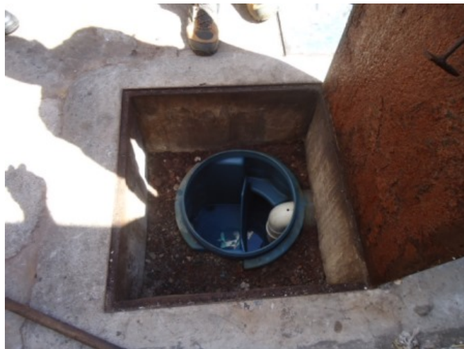
Foto 13: Módulo medidor de vazão com coleta de amostras Pista de Abastecimento..
