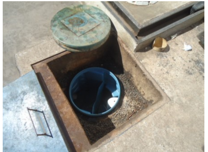
Foto 9: Módulo medidor de vazão com coleta de amostras - Área das descargas seladas.
