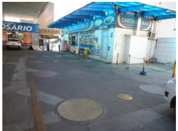
Foto 3: Área de tancagem localizada nas margens da pista de abastecimento.
