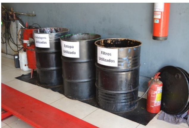
Foto 17: Segregação dos resíduos da área de lubrificação, devidamente sinalizado e separado por tipo de resíduo.
