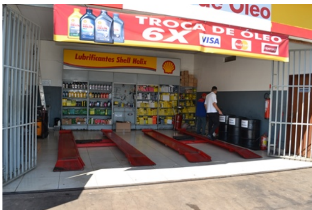
Foto 14: Área de lubrificação com canaletas circundando a área.
