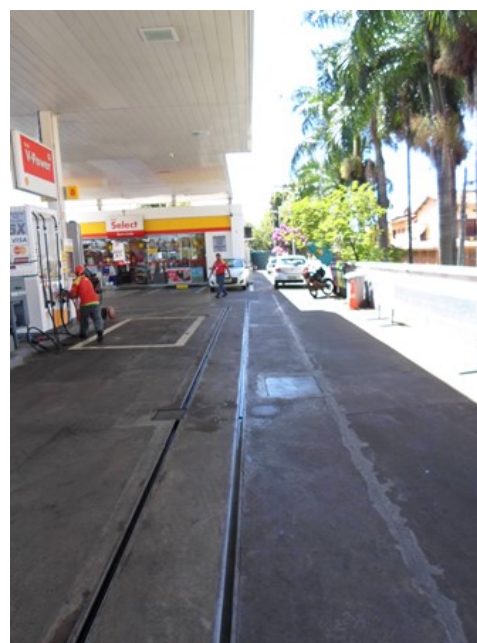
Foto 11: Canaletas do SAO e da drenagem pluvial sob a projeção da cobertura, em bom estado de conservação.
