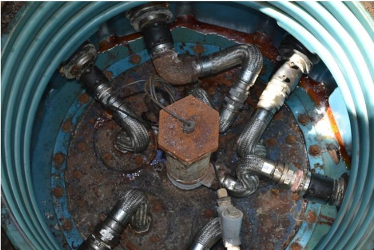
Figura 11 - Câmara de contenção do tanque subterrâneo, sem manutenção adequada.
