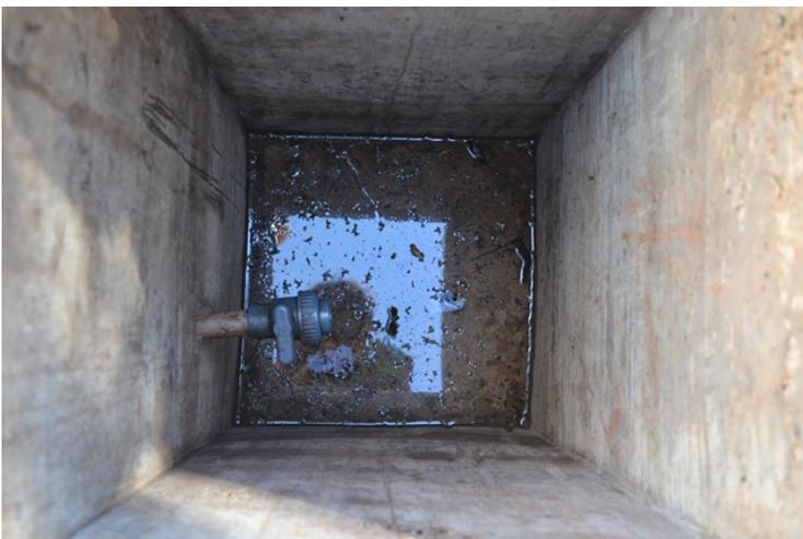
Foto 19 - Caixa coletora de óleo da área de abastecimento.
