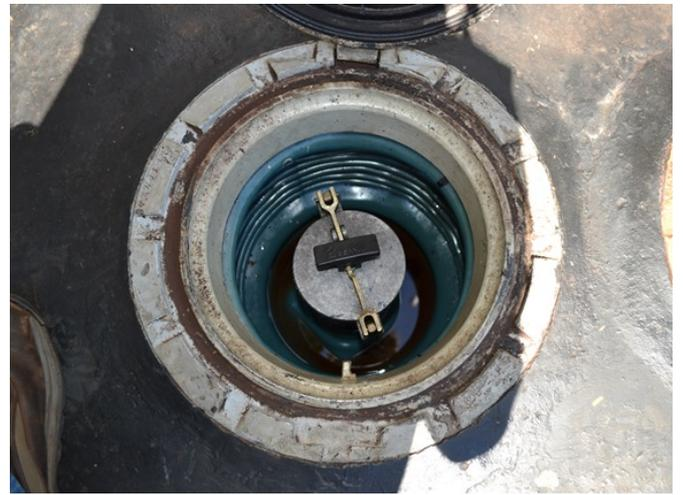
Figura 4 - Detalhe da câmara de contenção da descarga selada à distância manutenção adequada.
