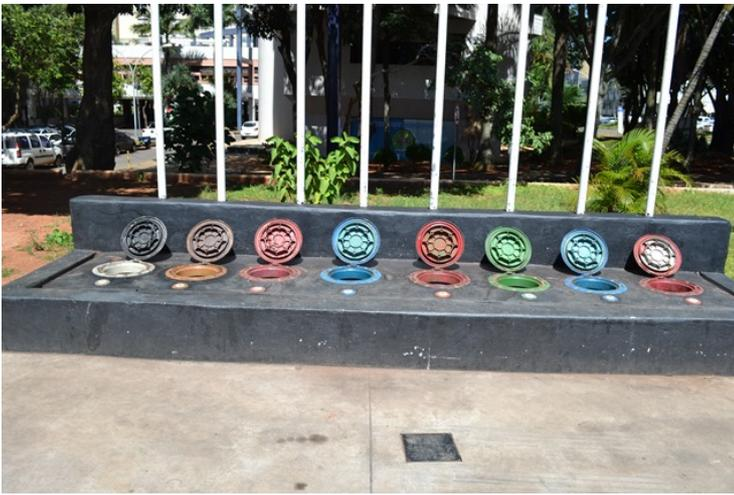
Figura 3 - Visão geral das descargas seladas à distância, todas com câmara de contenção.
