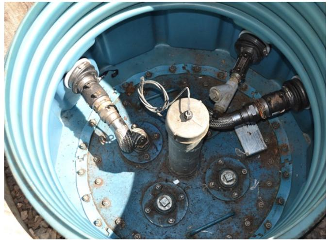
Foto 10 - Câmara de contenção do tanque subterrâneo, sem manutenção adequada.
