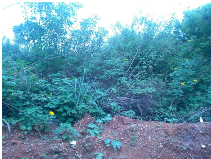
FOTO 3: Trecho de passagem do extravasor da elevatória EEB.CPS.001 em área com ocorrência de processo erosivo e vegetação exótica invasora.
