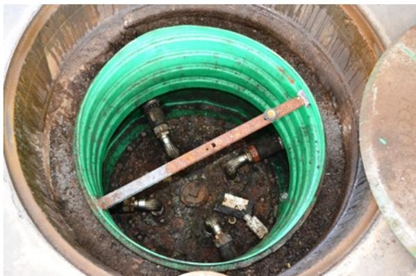
**Figura 10** - Aspecto da Câmara de contenção na boca de visita do tanque com controle eletrônico de estoque, tubulação metálica flexível, tubulação subterrânea em PEAD e flanges de vedação. Observa-se a corrosão na tampa do tanque necessitando de manutenção.
