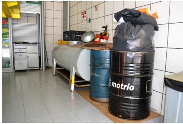
**Figura 23** - Aspecto do tanque OLUC e dos tambores para a segregação dos resíduos perigosos classe I.
