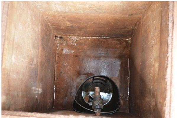
**Figura 43** - Caixa coletora de óleo da área de lavagem e manutenção. Não foi possível fazer o registro fotográfico da caixa de amostragem de efluentes em função de está inacessível.
