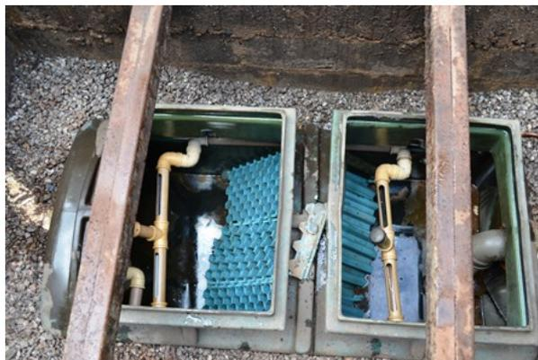
**Figura 40** - Aspecto da caixa separadora de água e óleo do SAO da pista de abastecimento.
