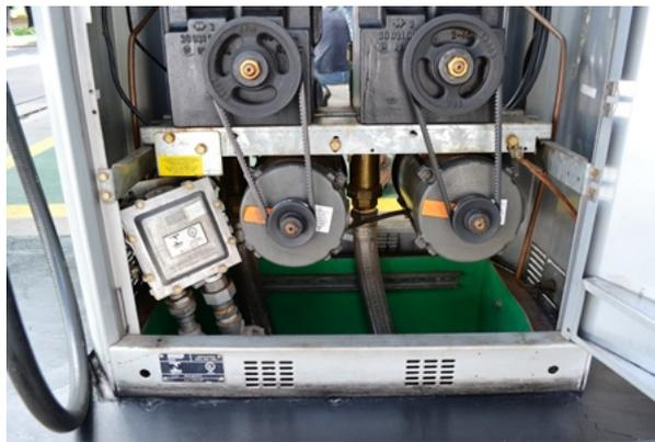
**Figura 3** - Unidade abastecedora de Etanol e Gasolina Comum com *check-valve*, observa-se que a tubulação está limpa e totalmente contida na câmara de contenção para unidade da bomba.
