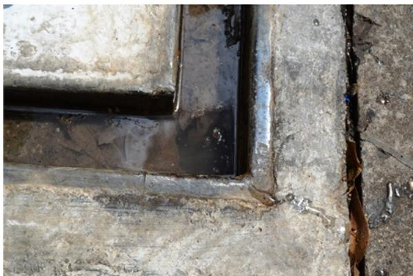
**Figura 6** - Canaletas da Descarga selada à Distância. Observa-se o acúmulo de água e a presença de alguns resíduos denotando a falta de manutenção no sistema de drenagem oleosa - SDO.
