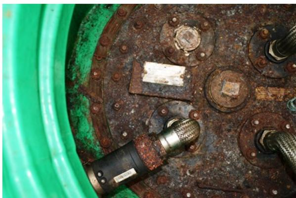
**Figura 11** - Detalhe interno da Câmara de contenção na boca de visita do tanque com as linhas subterrâneas de distribuição em material pead. Observa-se o detalhe da coifa dos flanges de vedação, tampa do tanque no qual apresentam corrosão no que denota a falta de manutenção.
