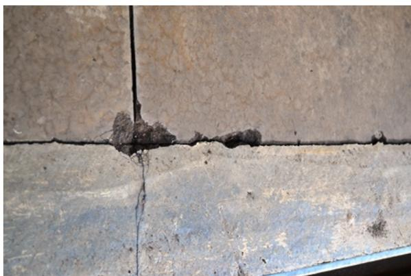
**Figura 8** - Fissuras no piso da pista de abastecimento próxima aos canaletes.
