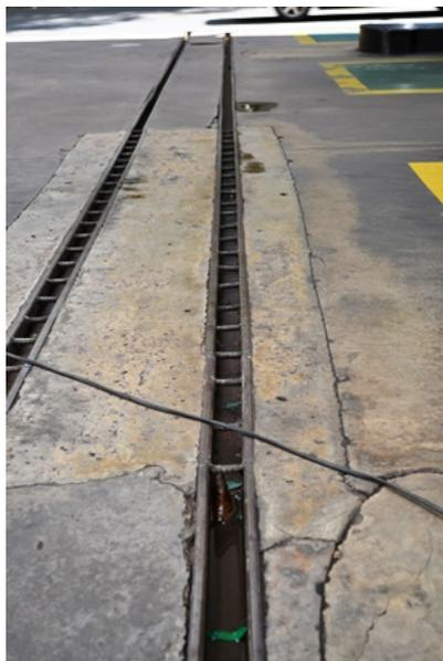
**Figura 7** - Canaletas da pista de Abastecimento com resíduos na estrutura interna, o mesmo precisa de manutenção periódica. Observa-se que algumas extremidades da canaleta não está contígua com o piso da pista de abastecimento.
