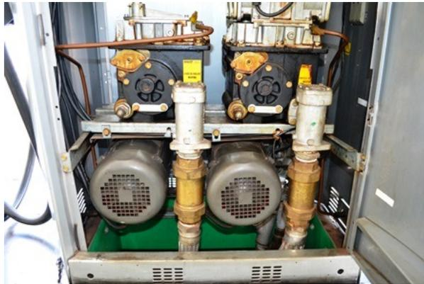
**Figura 2** - Detalhe da unidade abastecedora de combustível com sistema de segurança *check-valve*.
