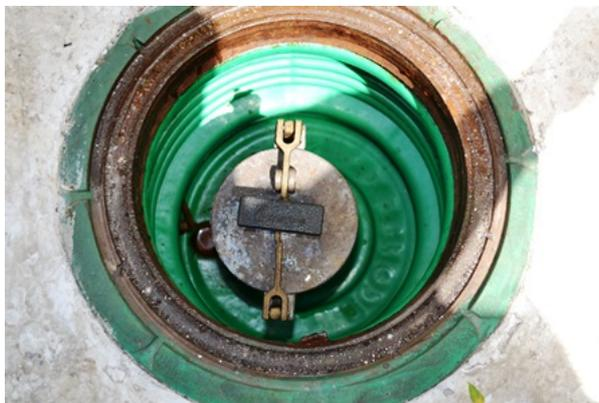
**Figura 15** - Descarga selada à distância. Observa-se que o dispositivo está em bom estado de conservação.
