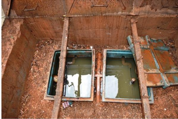
**Figura 42** - Aspecto da caixa separadora de água e óleo do SAO da área de lavagem e manutenção de veículos. A caixa necessita de manutenção operacional semanal conforme exige o item 4.3 tabela 1 da ABNT NBR 15594-3:2008.
