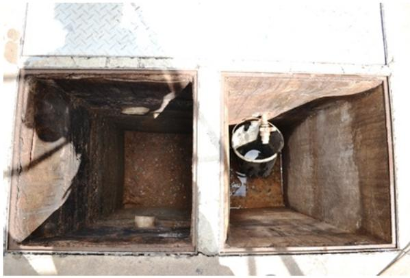
**Figura 41** - Caixa de amostragem de efluentes (esquerda) e caixa coletora de óleo (direita) da área de abastecimento.
