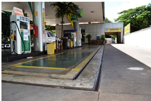
**Figura 4** - Unidades Abastecedoras do SASC. Observa-se que a pista de abastecimento possui duas canaletas, sendo a primeira (interna) direcionada para o SAO e a segunda (externa) direcionada para a drenagem de águas pluviais conforme exige parágrafo 4 art 21 da instrução 213/2013.
