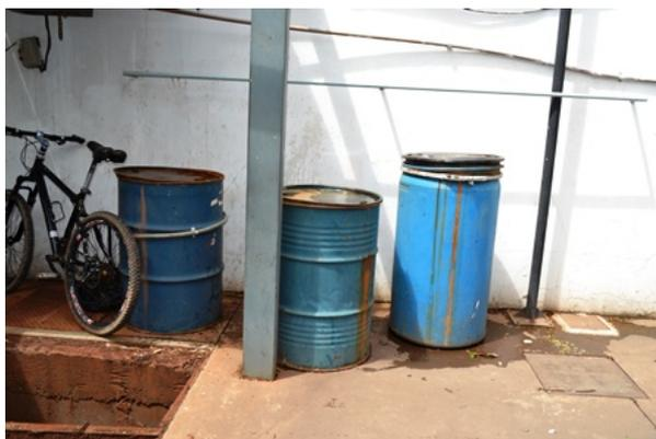
Figura 21 - Compartimentos com resíduos classe 1. Observa-se que o resíduo está acondicionado em local descoberto e não circundado por canaletas.
