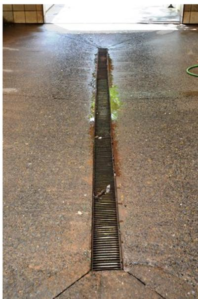
**Figura 19** - Aspecto da caixa de areia central da área de lavagem de veículos. Observa-se o caimento da superfície da pista.
