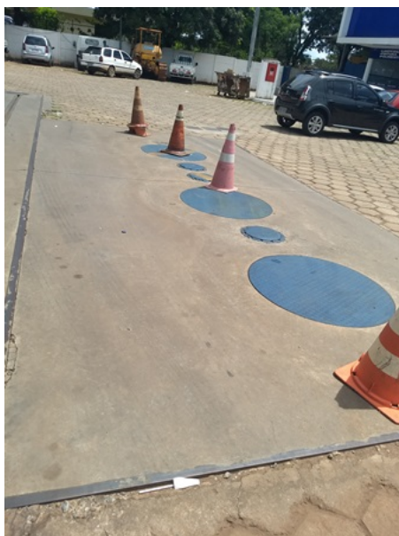
Figura 2 - Área de tancagem adjacente a pista de abastecimento.
