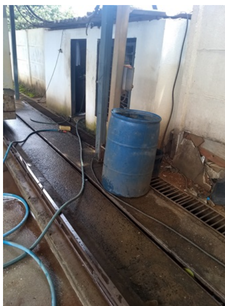
Figura 29 - Área de lavagem de veículos circundada com canaleta.
