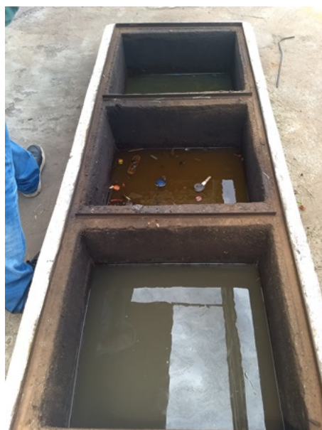
Figura 30 - Sistema Separador de Água e Óleo - SAO da área de lavagem de veículos, em desacordo com as normas da CAESB.
