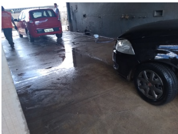
Figura 36 - Área de lavagem de veículos sem canaletas localizada no interior do empreendimento com caixa de areia central.
