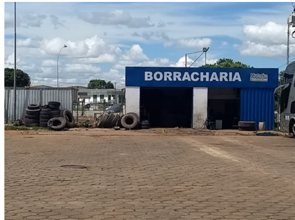
Figura 39 - Área da Borracharia com pneus dispostos inadequadamente.
