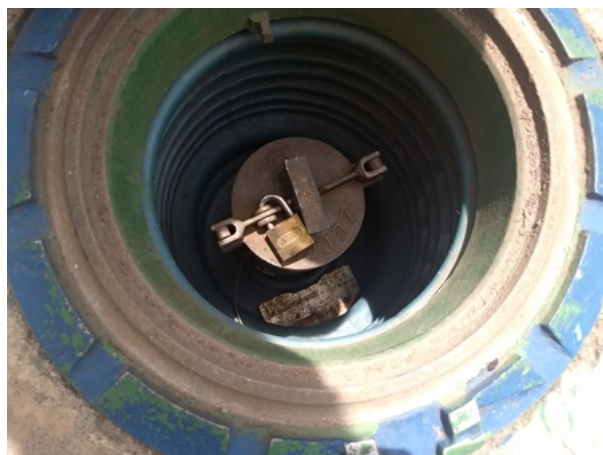
Figura 4 - Descarga selada com câmara de contenção e placa da válvula de anti-transbordamento.
