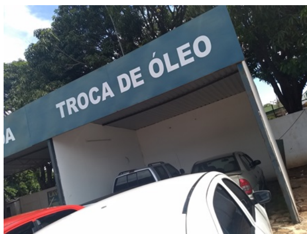
Figura 31 - Área de lubrificação do Posto desativada.
