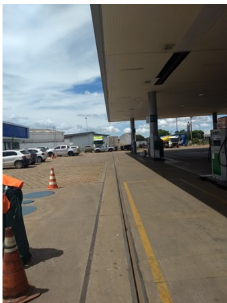
Figura 8 - Pista de abastecimento com canaletos circundando a área e dentro da projeção da cobertura.
