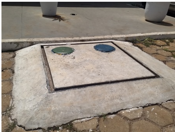
Figura 22 - Descargas seladas à distância com as canaletas circundando a área.
