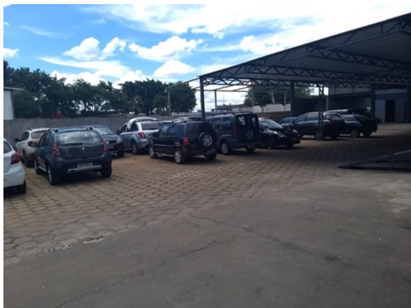
Figura 32 - Pátio interno do empreendimento com atividades de lubrificação, pintura e lavagem de veículos.
