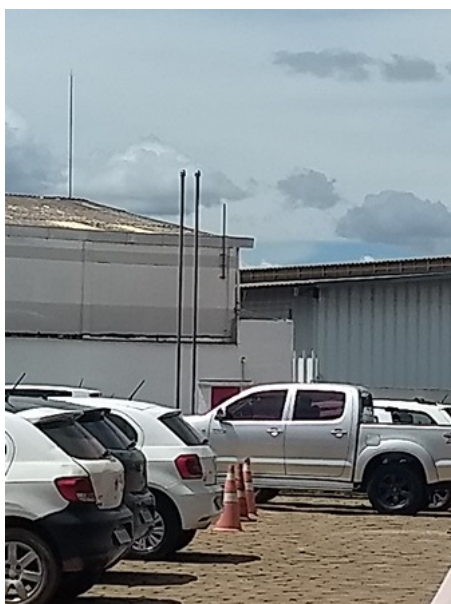
Figura 6 - Dois respiros com terminais corta-chamas em uma extremidade do posto.
