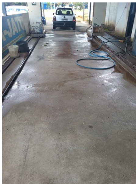
Figura 27 - Área de lavagem de veículos circundada com canaleta mas sem caixa de areia central.
