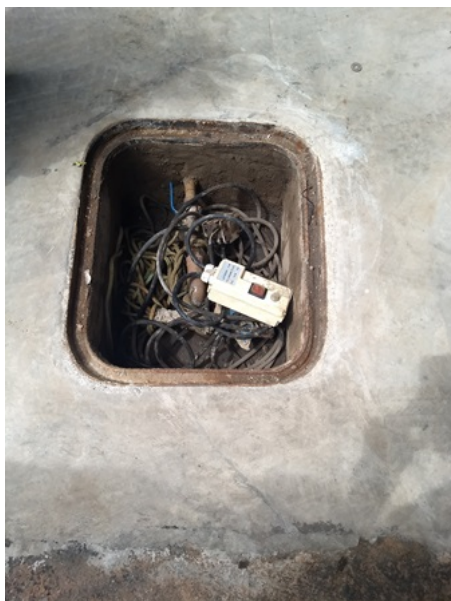
Figura 34 - Captação de água subterrânea por outorga da ADASA.
