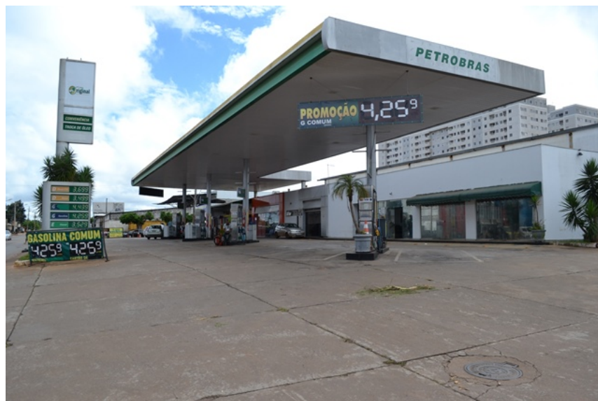
Foto 1. Visão geral do empreendimento.
