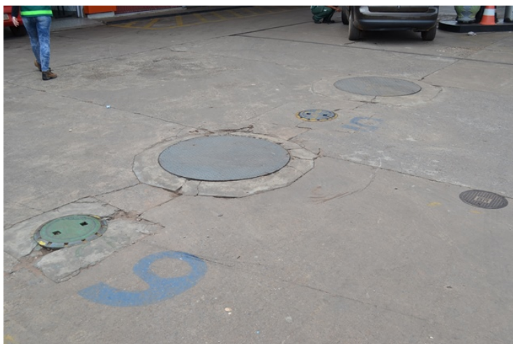
Foto 11. Visão do Sistema Subterrâneo de Armazenamento de Combustível - SASC. Foto 12. Descarga selada sobre o tanque. Observa-se a presença de resíduos líq
