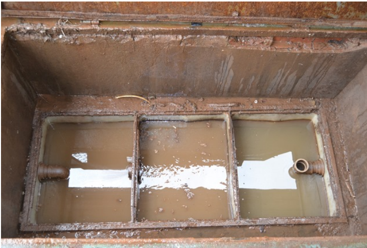
Foto 25. SAO da área de lavagem.
