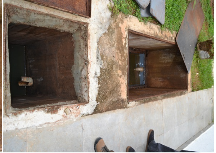
Foto 24. Visão geral do SAO da área de abastecimento.
