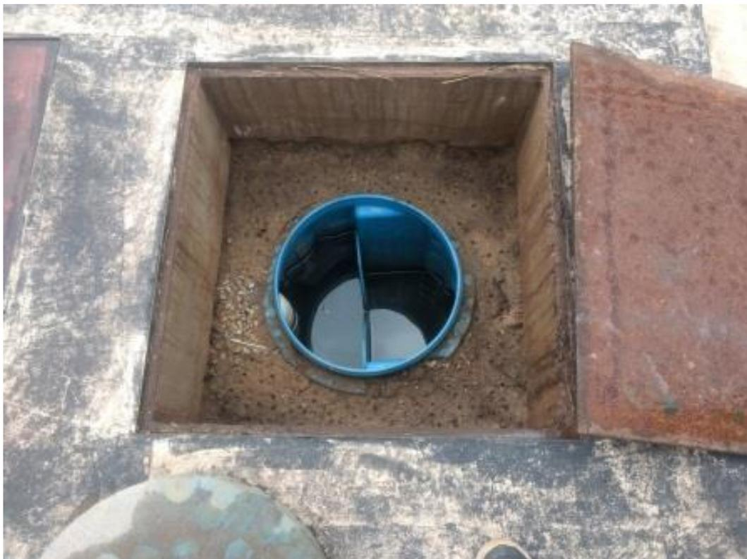
**Figura 22** - Módulo medidor de vazão com coleta de amostras - Pista de Abastecimento.
