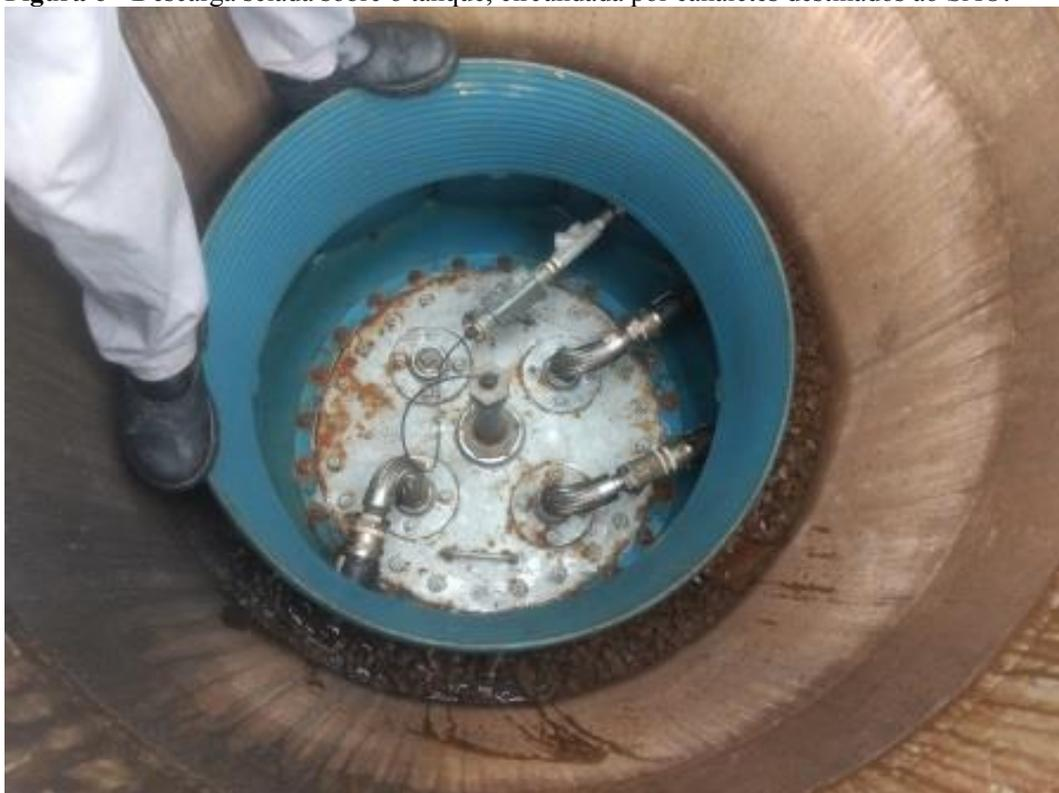
**Figura 7** - Acesso a boca de vista do tanque, com câmara de contenção.
