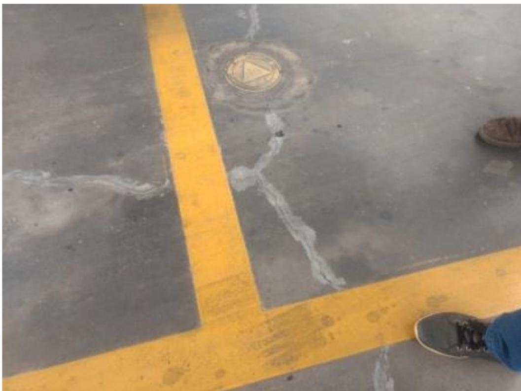
**Figura 18** - Formação de rachaduras, mesmo após impermeabilização da pista.
