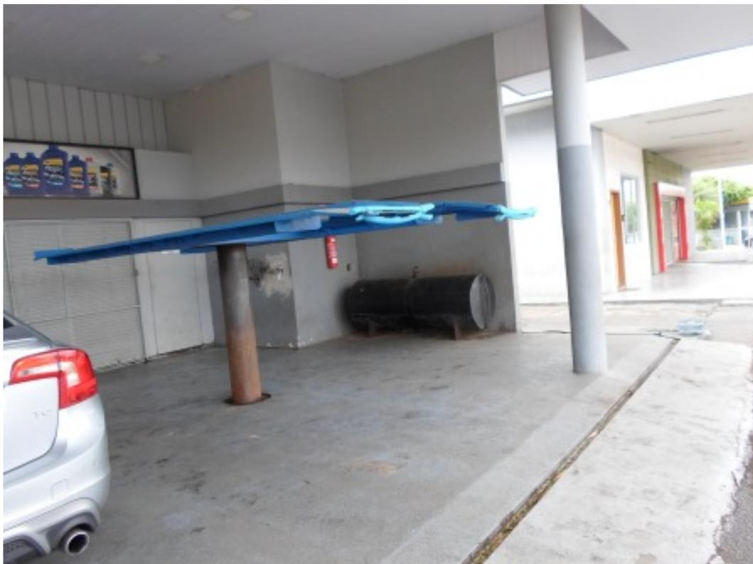
**Figura 30** - Tanque de OLUC, localizado na área de lubrificação de veículos não atendida por sistema separador de água e óleo.
