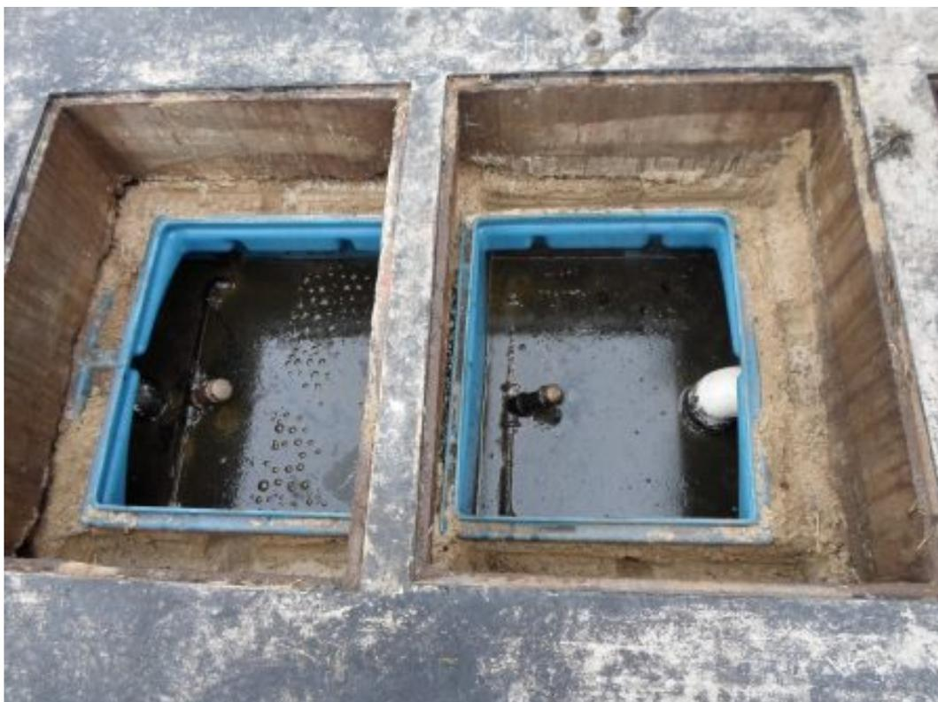
**Figura 20** - Caixa separadora de água e óleo - Pista de Abastecimento.
