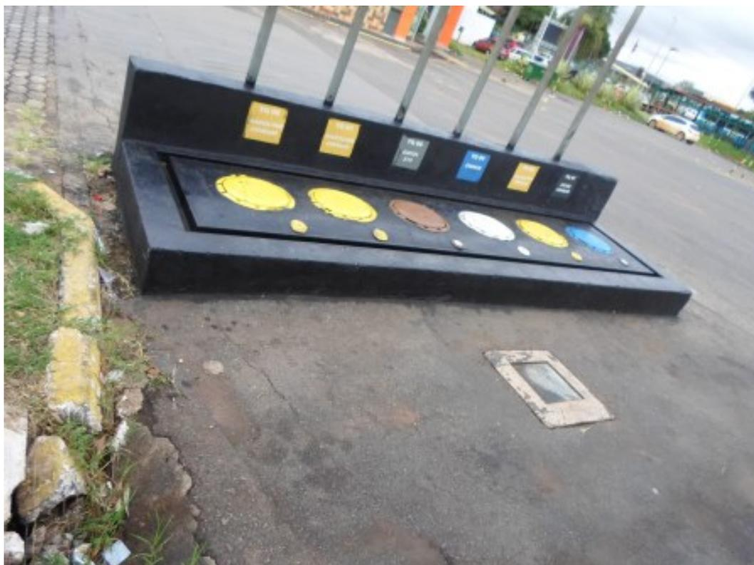
**Figura 10** - Descargas seladas a distância, circundadas por canaletas destinadas ao SAO.
