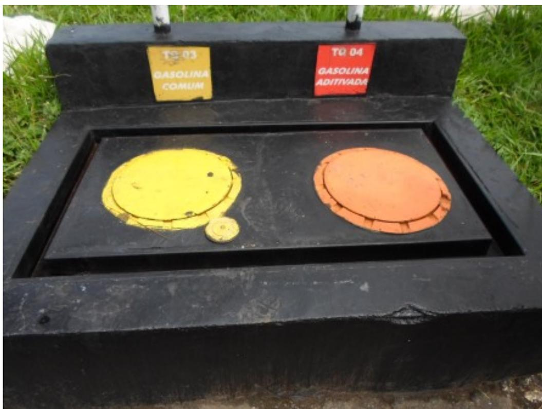
**Figura 12** - Segunda área de descargas seladas à distância.
