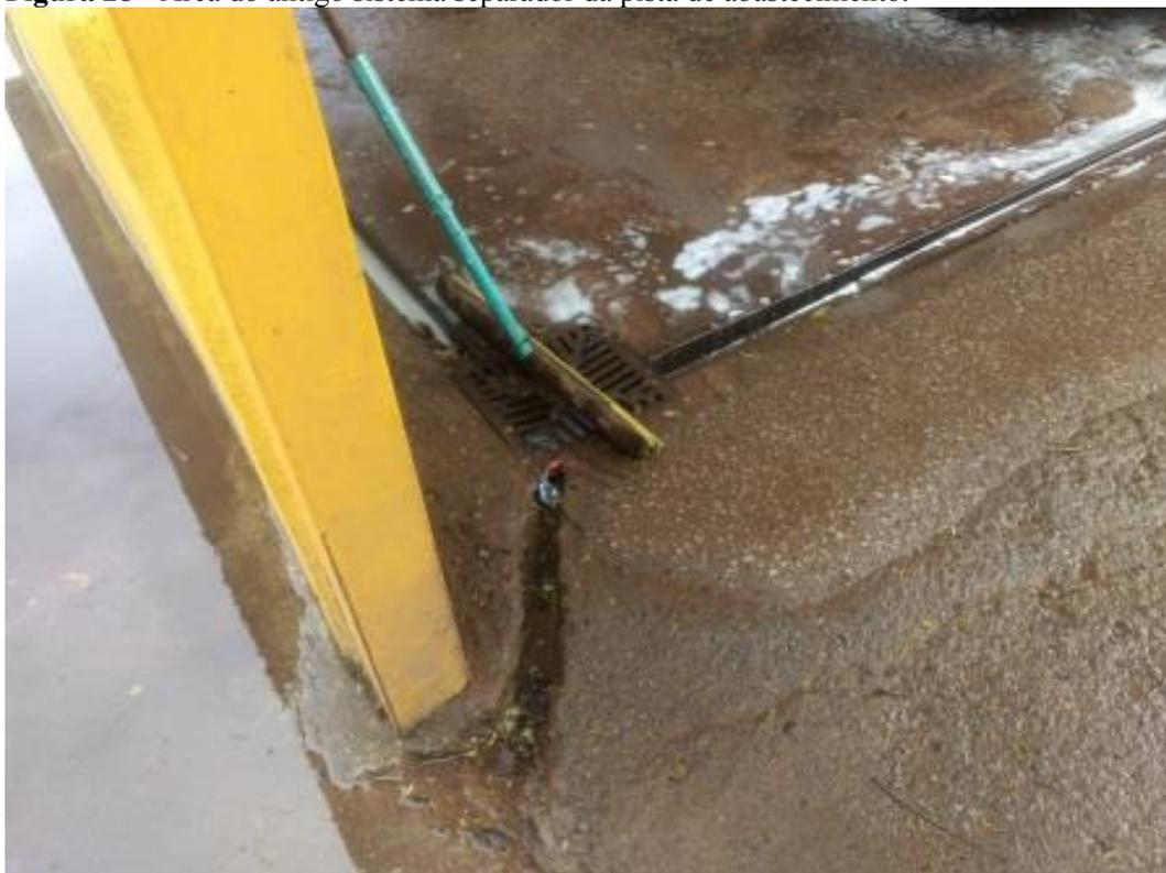
**Figura 29** - Detalhe dos canaletos do SDO da área de lavagem de veículos, observa-se extravasor para fora do sistema.
