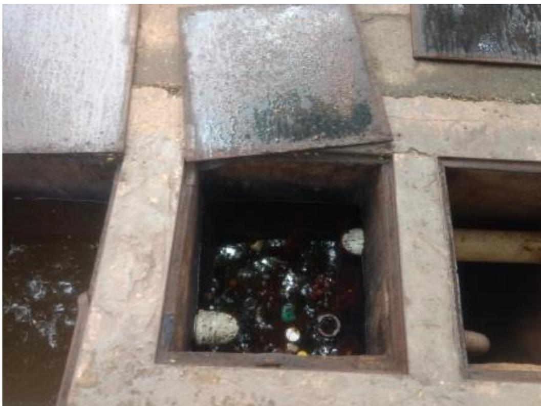
**Figura 26** - Detalhe da caixa separadora com a presença de sólidos grosseiros.
