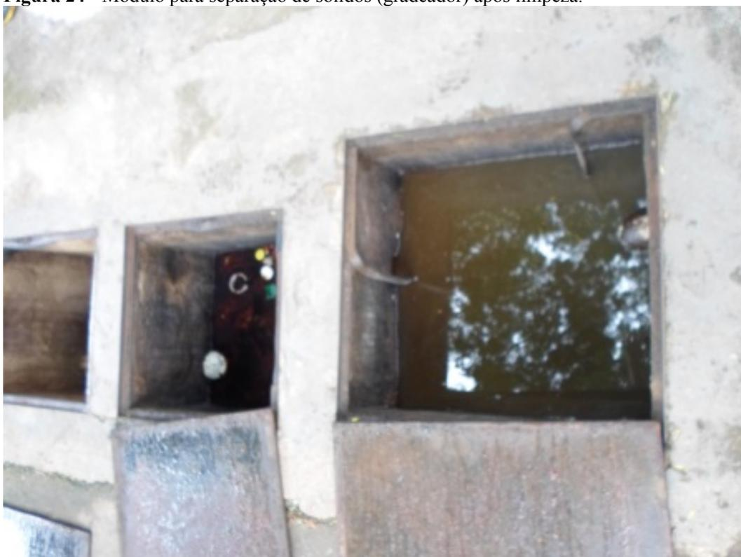
**Figura 25** - Sistema Separador Água e Óleo da Área de Lavagem de Veículos.
