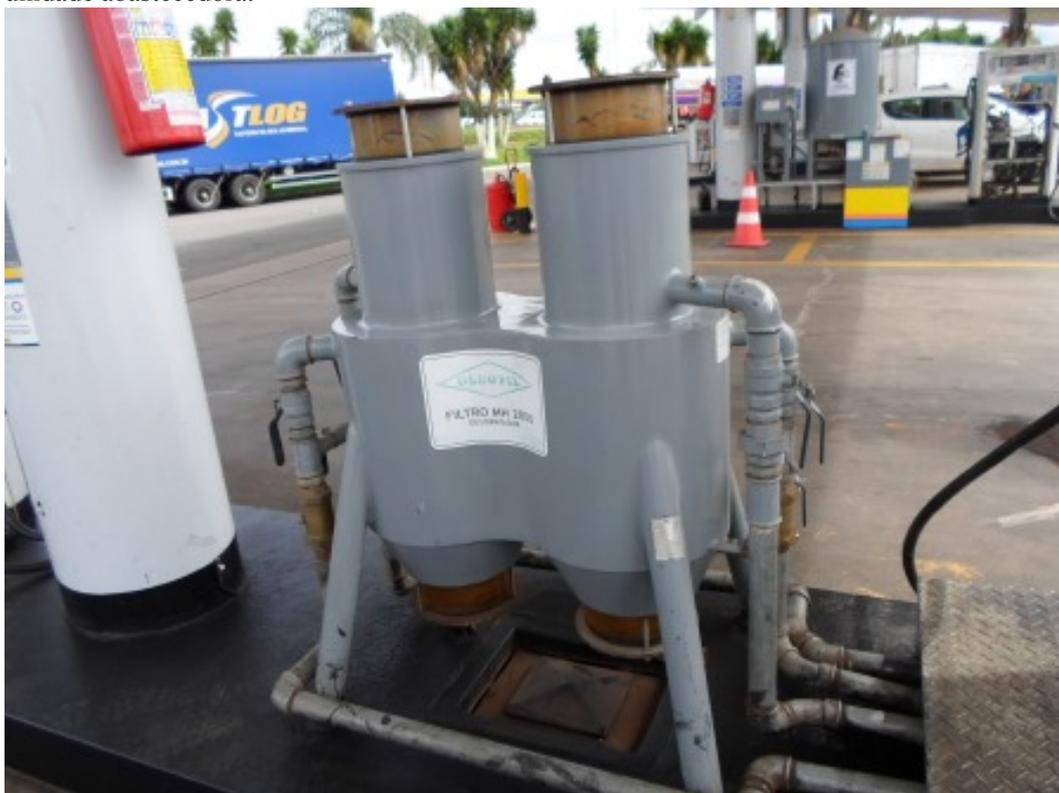
**Figura 15** - Segundo filtro de diesel.
