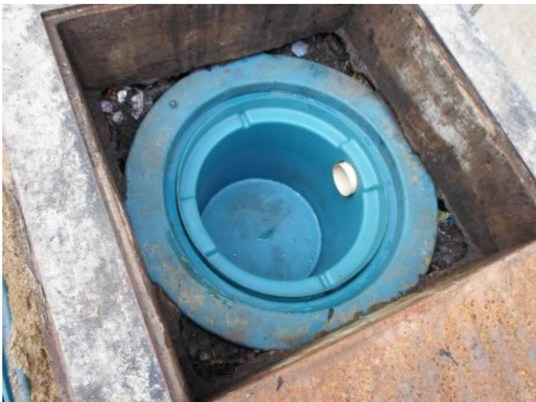
**Figura 24** - Módulo para separação de sólidos (gradeador) após limpeza.
