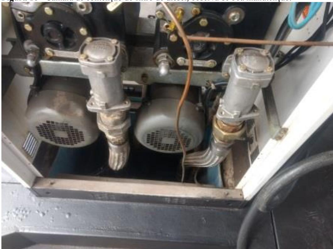
**Figura 17** - Câmara de contenção da unidade de abastecimento, observa-se que toda a tubulação que transporta combustível está contida dentro dos limites da câmara, *check valve* e boa manutenção do equipamento.
