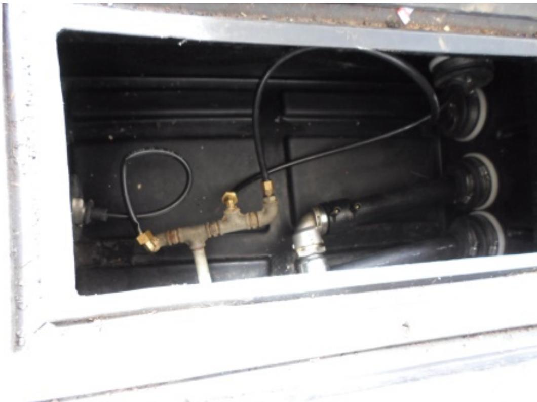
**Figura 16** - Câmara de contenção do filtro de diesel, observa-se boa manutenção.
