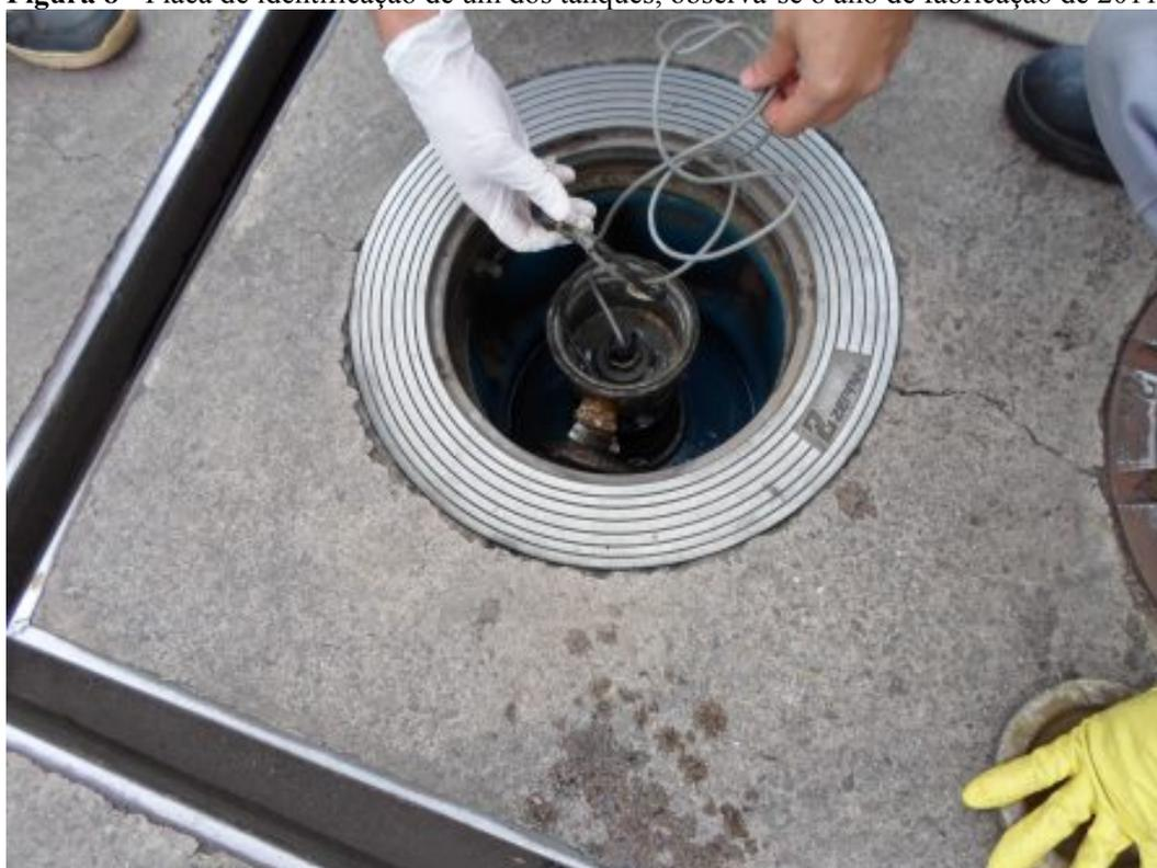
**Figura 9** - Câmara do monitoramento intersticial, observa-se o sensor instalado.
