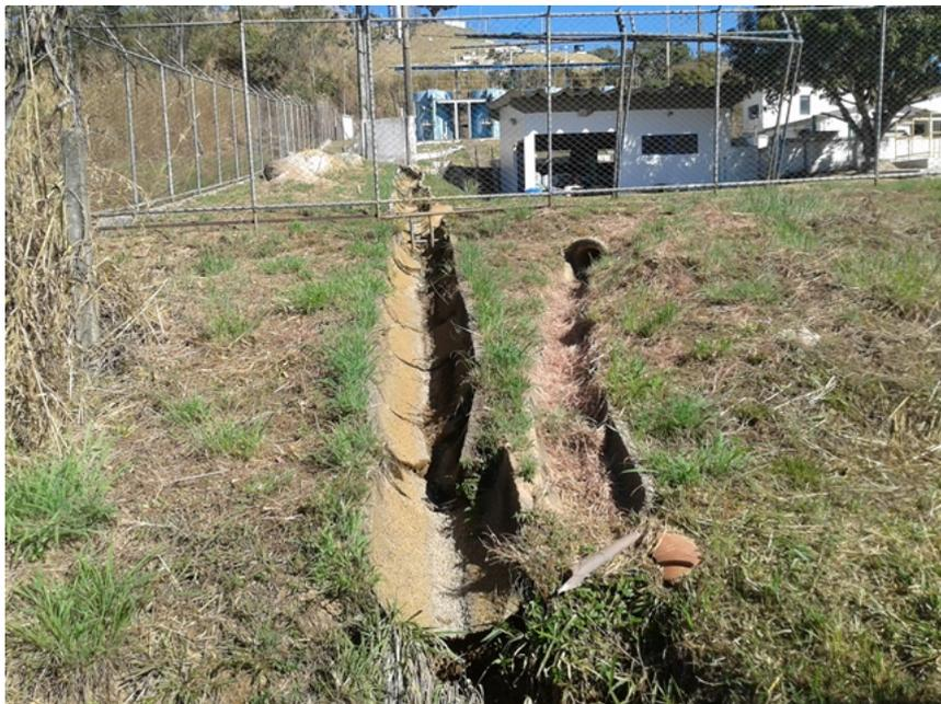
Foto 5: Canaletas de descarte da água de lavagem dos filtros.
