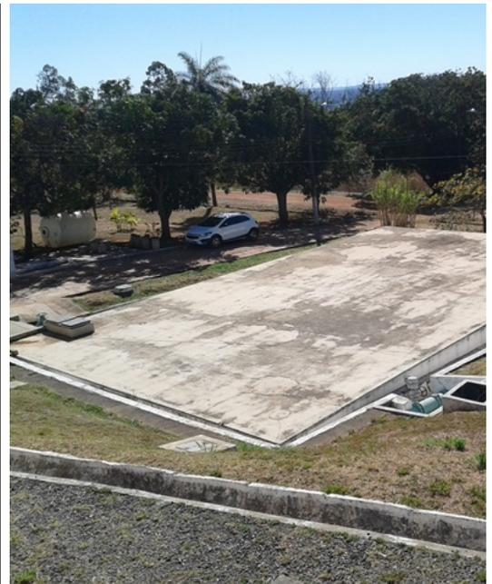
Foto 4: Tanque de contato e reservatório de distribuição.
