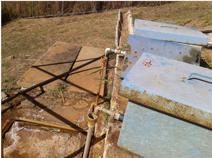
Foto 3: Adição de sulfato de Alumínio (coagulante).
