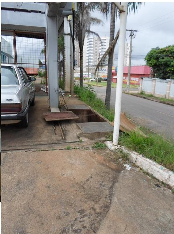
**Figura 17** - Sistema Separador de Água e Óleo - SAO da pista de abastecimento área de lubrificação e descarga a distância.
