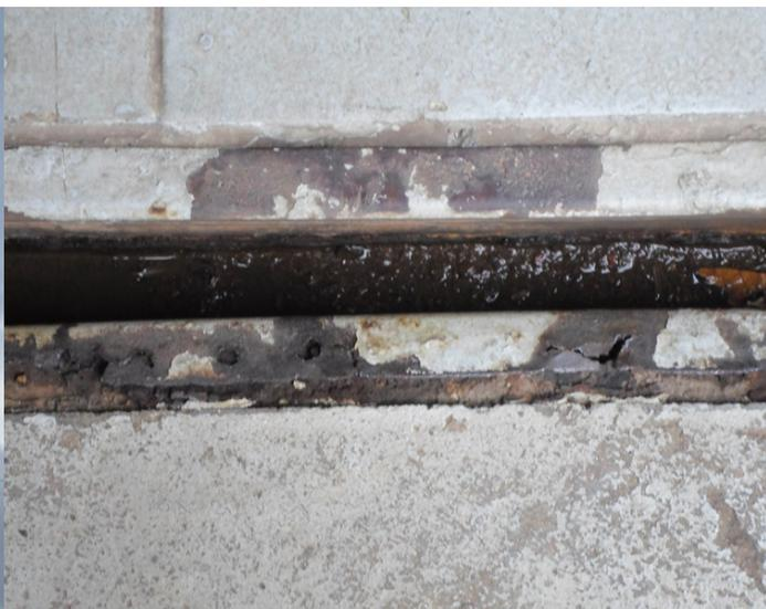
**Figura 7** - Canaletas enferrujadas e sem manutenção adequada na área de lubrificação de veículos.
