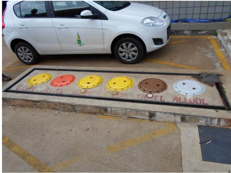
**Figura 24** - Descargas seladas à distância com as canaletas circundando a área.
