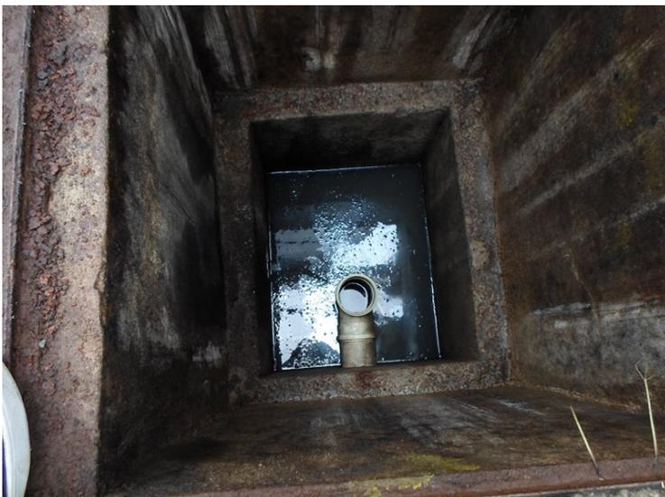
**Figura 18** - Caixa de Areia do SAO da pista de abastecimento, área de lubrificação e descarga a distância.
