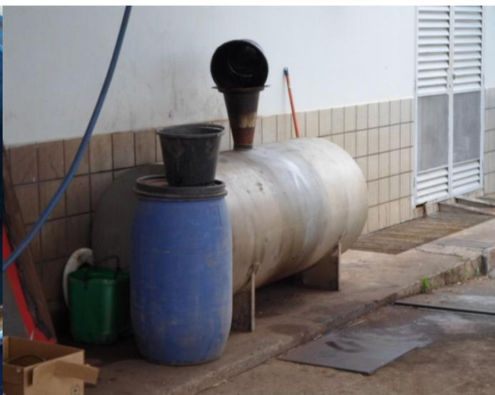
**Figura 15** - Tanque de estocagem de OLUC aéreo em local inadequado, com piso impermeabilizado mas sem canaletas na área (antiga área de lavagem de veículos).
