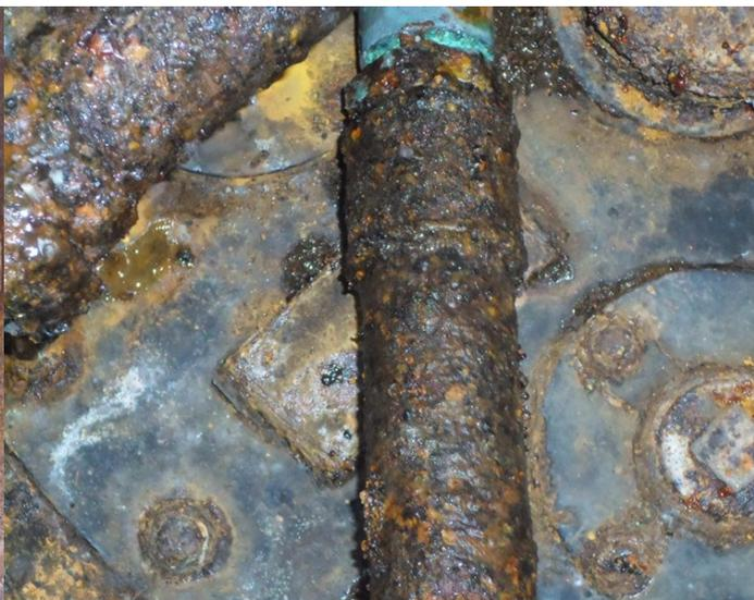
**Figura 5** - Detalhe da tubulação do SASC em aço em estado evidente de oxidação.
