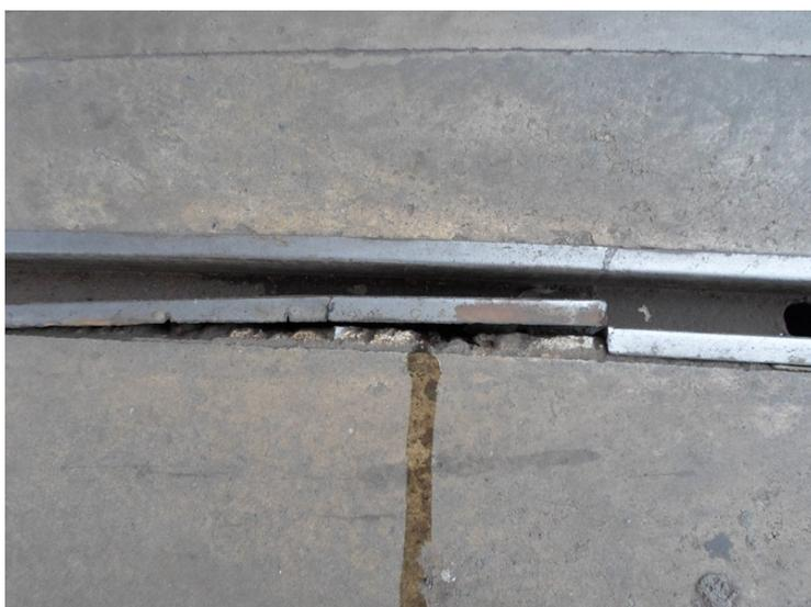
**Figura 8** - Detalhe das canaletas amassadas e soltas da pista de abastecimento.
