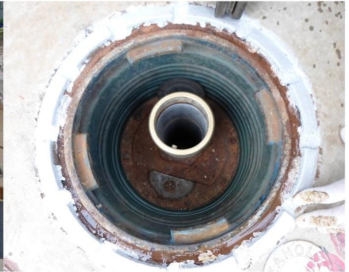
**Figura 25** - Descarga selada à distância com câmara de contenção.
