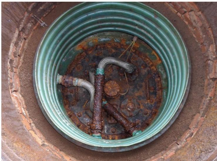
**Figura 4** - Boca de visita de um dos tanques com câmara de contenção.
