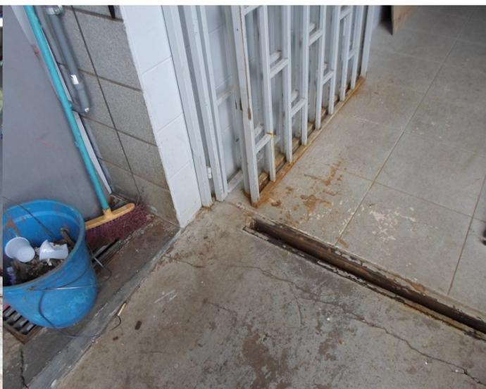
**Figura 13** - Área de lubrificação com canaletas na entrada sem abrangência total exigida.
