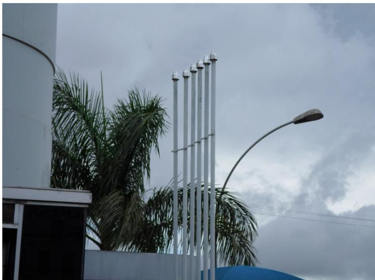
**Figura 6** - Respiros dos tanques com os seis terminais corta chamas livre de obstrução.
