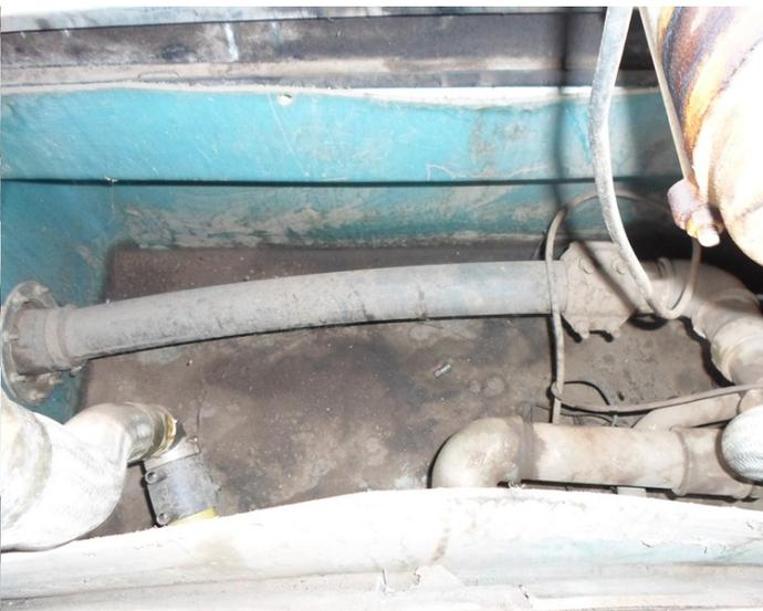
**Figura 22** - Unidade de abastecimento com seis bicos injetores e com câmara de contenção deformada.
