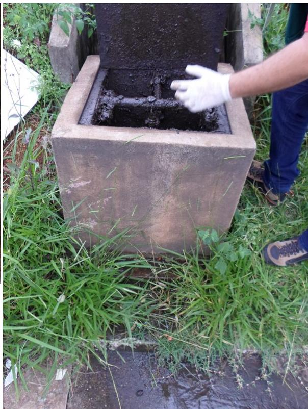
**Figura 19** - Caixa de passagem do SAO da pista de abastecimento com vazamen
