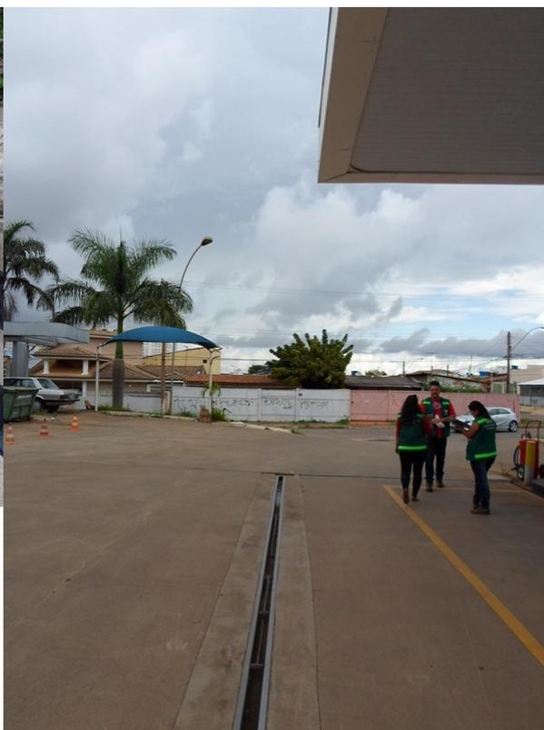
**Figura 11** - Canaletas da unidade de filtragem de diesel fora da abrangência da projeção da cobertura.
