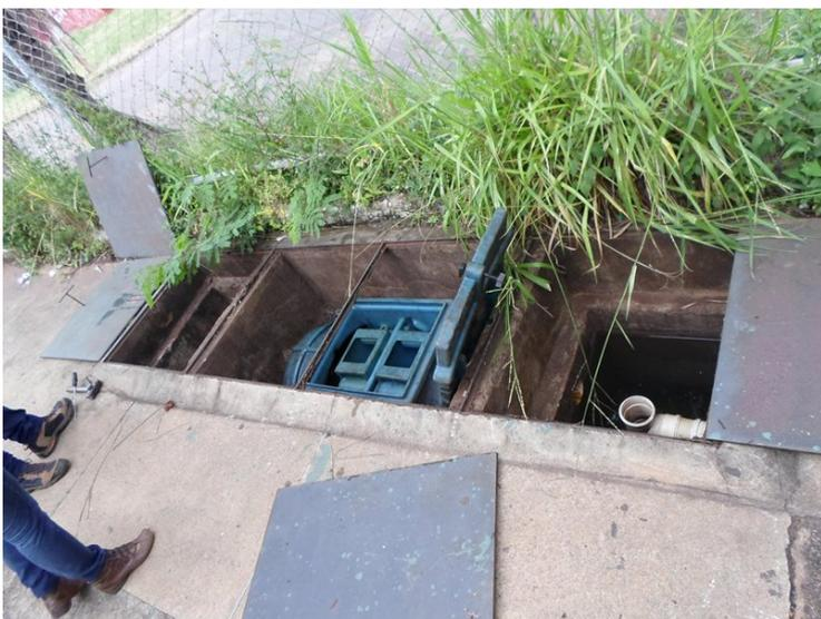
**Figura 20** - Sistema Separador de Água e Óleo - SAO da Área de Lavagem de Veículos desativada.
