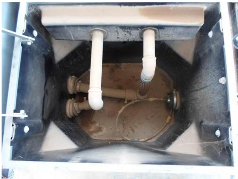
Foto 3 – Câmara de Contenção para Unidade de Filtragem, localizada na pista de abastecimento.
