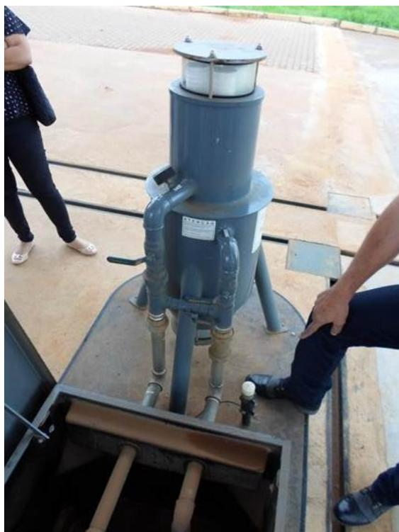
Foto 2 – Filtro de Diesel localizado na pista de abastecimento circundada por canaletas.
