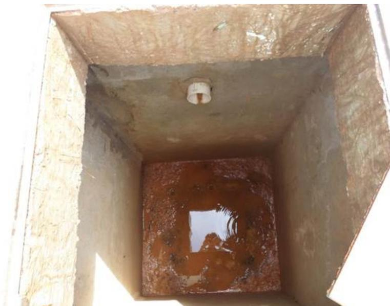
Foto 7 – Caixa de amostragem do SAO da pista de abastecimento
