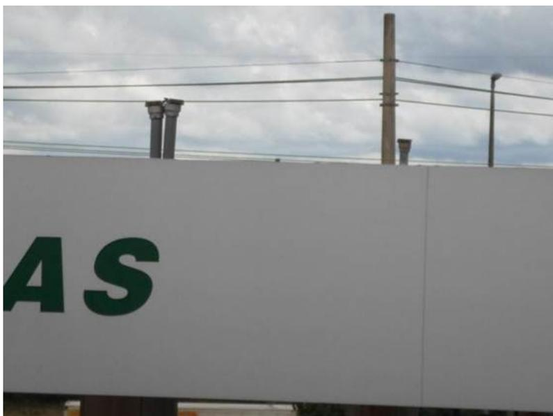
Foto 12 - Respiros com terminal corta-chamas, a foto evidencia a necessidade de adequação.
