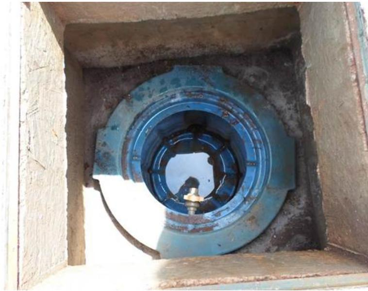
Foto 8 – Caixa Coletora do SAO da pista de abastecimento
