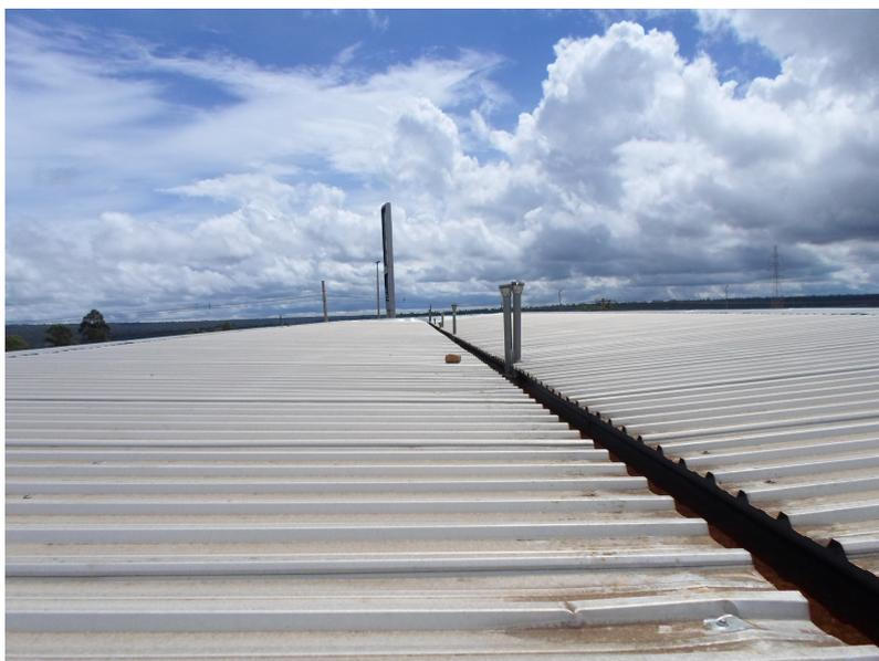
Foto 13: Vista geral do telhado da pista de abastecimento, onde é possível observar que os respiros não obedecem o raio esférico livre mínimo de 1,5 m.
