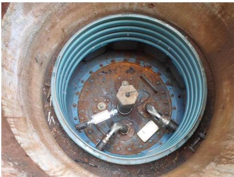
Foto 10 - Boca de Visita do Tanque evidenciando controle eletrônico de estoque, tubulação subterrânea de PEAD .
