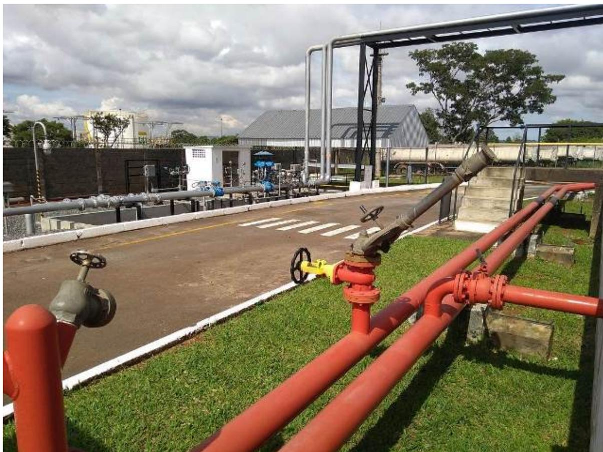
Foto 4 – Canhões d'água em volta da bacia onde estão contidos todos os tanques
