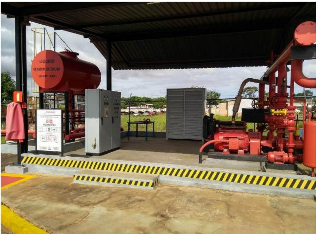
Foto 14 – Unidade de bombas da central de combate a incêndios
