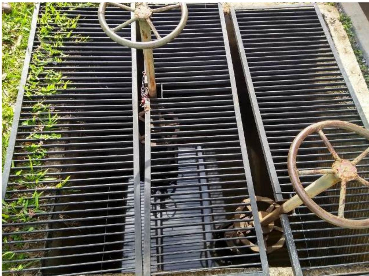
Foto 8 – Válvula que impede fluxo contínuo de efluentes ao SAO
