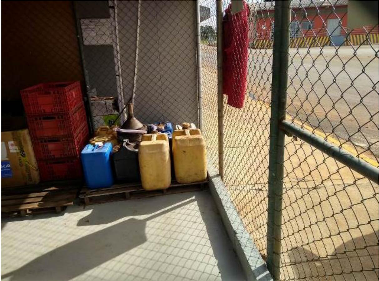
Foto 13 – Área de armazenamento de resíduos com piso impermeável e bacia de contenção
