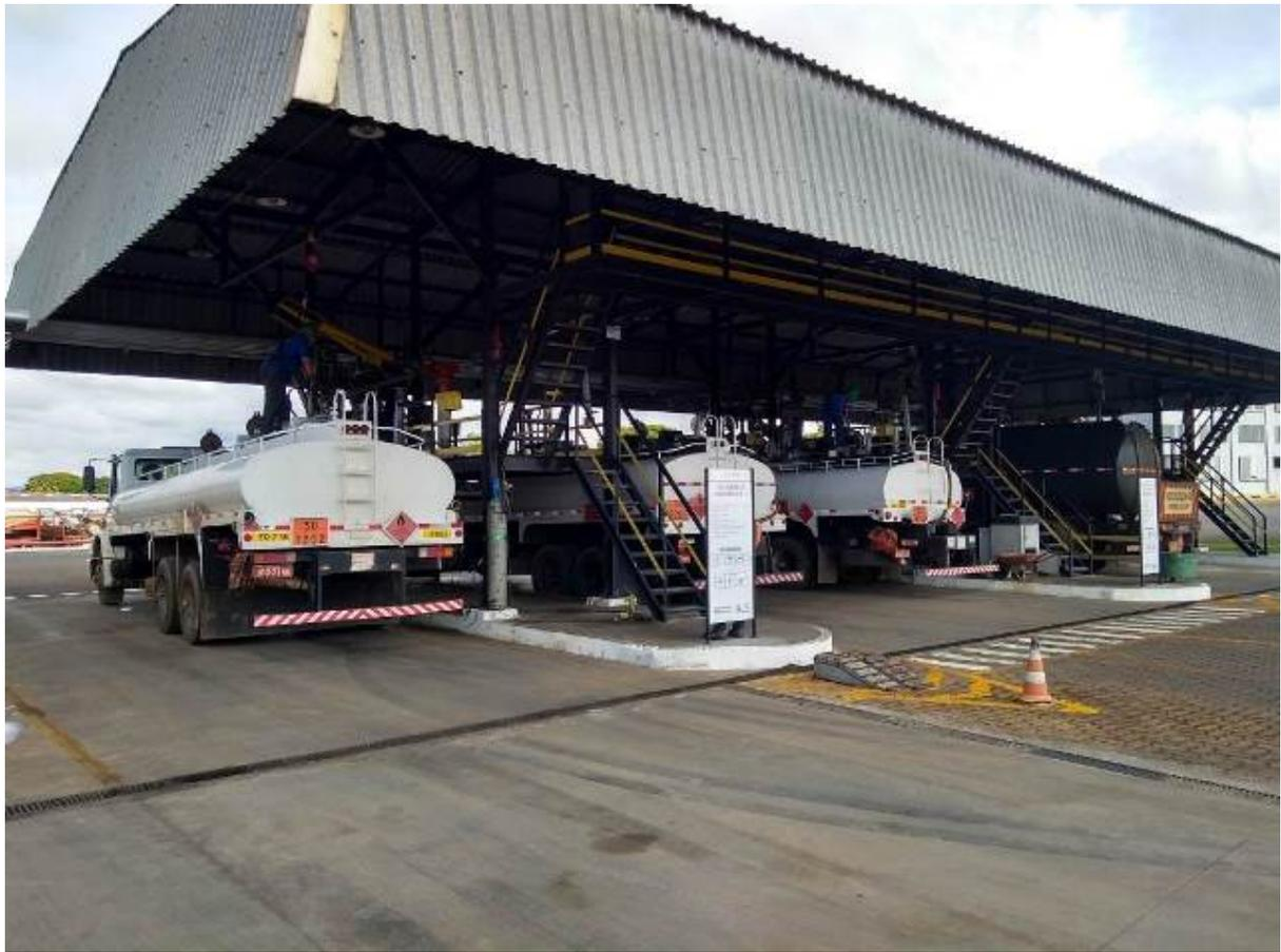
Foto 7 – Pista de abastecimento dos tanques dos caminhões com piso impermeável e canaletas direcionadas ao SAO
