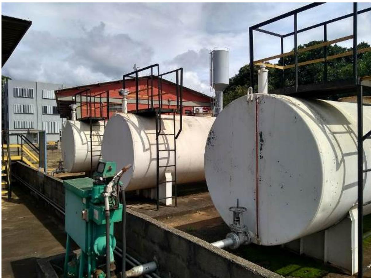
Foto 16 – Tanques de combustível do ponto de abastecimento
