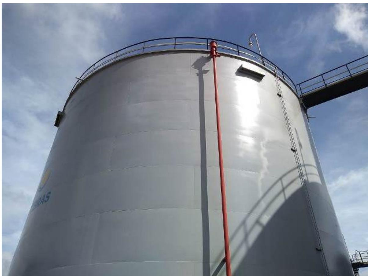
Foto 5 – Gerador de espuma no alto de todos os tanques.
