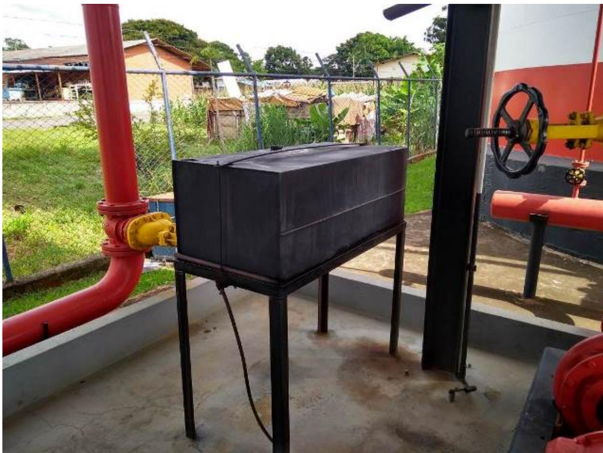
Foto 15 – Tanque de armazenamento de óleo Diesel que fornece combustível para a bomba d'água para combate à incêndio.
