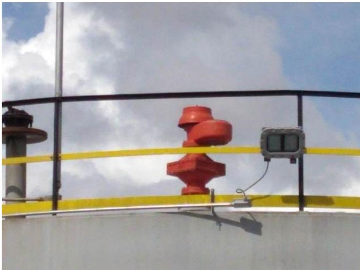
Foto 6 – Hidrante no topo de tanque. Este pode ser observado em todos os tanques
