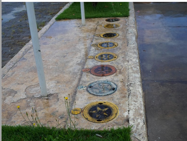
Figura 20 - Descargas seladas à distância sem as canaletas circundando a área.
