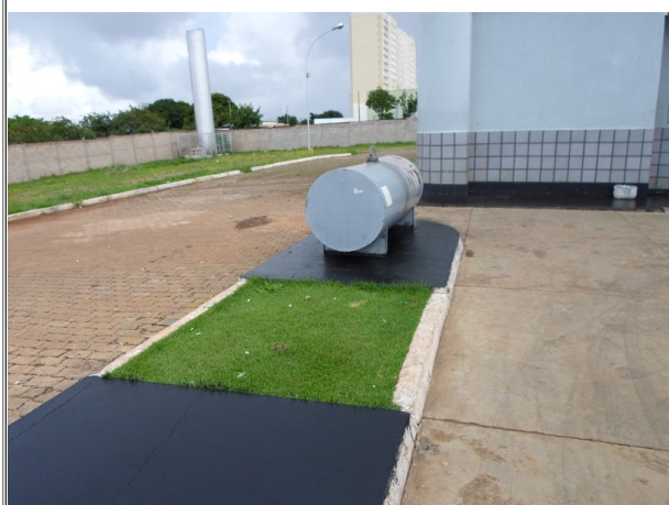
Figura 16 - Tanque de estocagem de OLUK aéreo com piso impermeabilizado mas sem canaletas na área.
