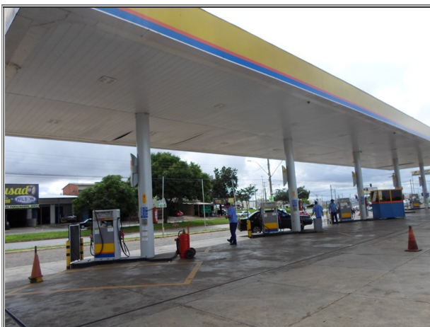
Figura 2 - Pista de abastecimento. É possível observar as canaletas circundantes ao posto.
