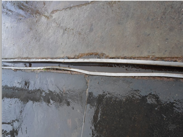
Figura 9 - Canaletas amassadas.
