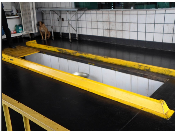
Figura 12 - Área de lubrificação com piso impermeabilizado em bom estado de conservação com vala central.
