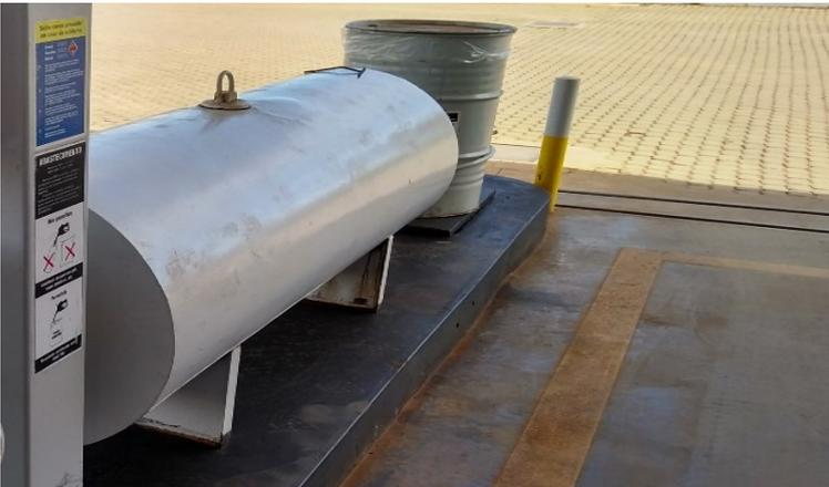
Figura 11: Tanque aéreo de armazenamento de óleo usado e contaminado.
