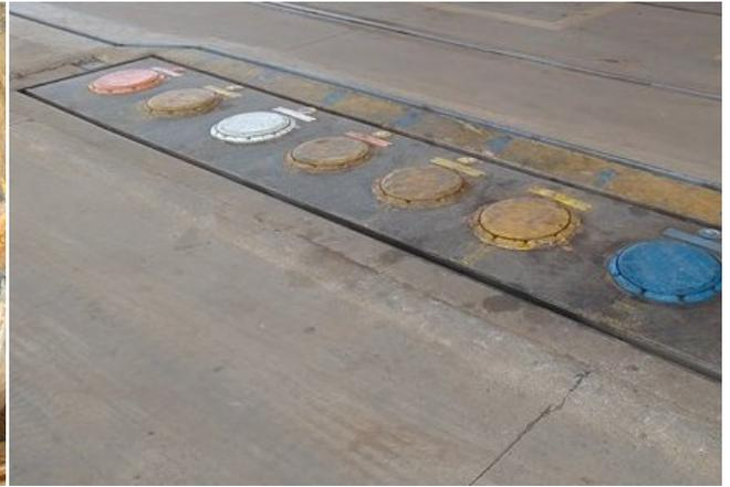
Figura 6: Descargas seladas à distancia, circundadas por canaletas.
