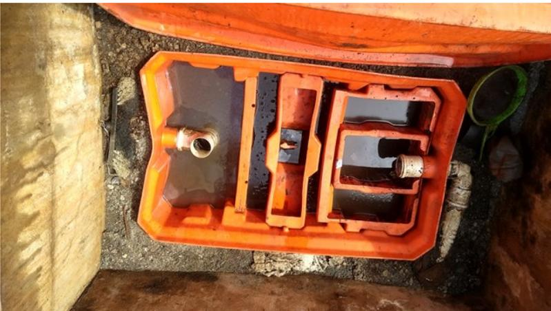
Figura 13: Sistema de separadores de água e óleo (SAO).
