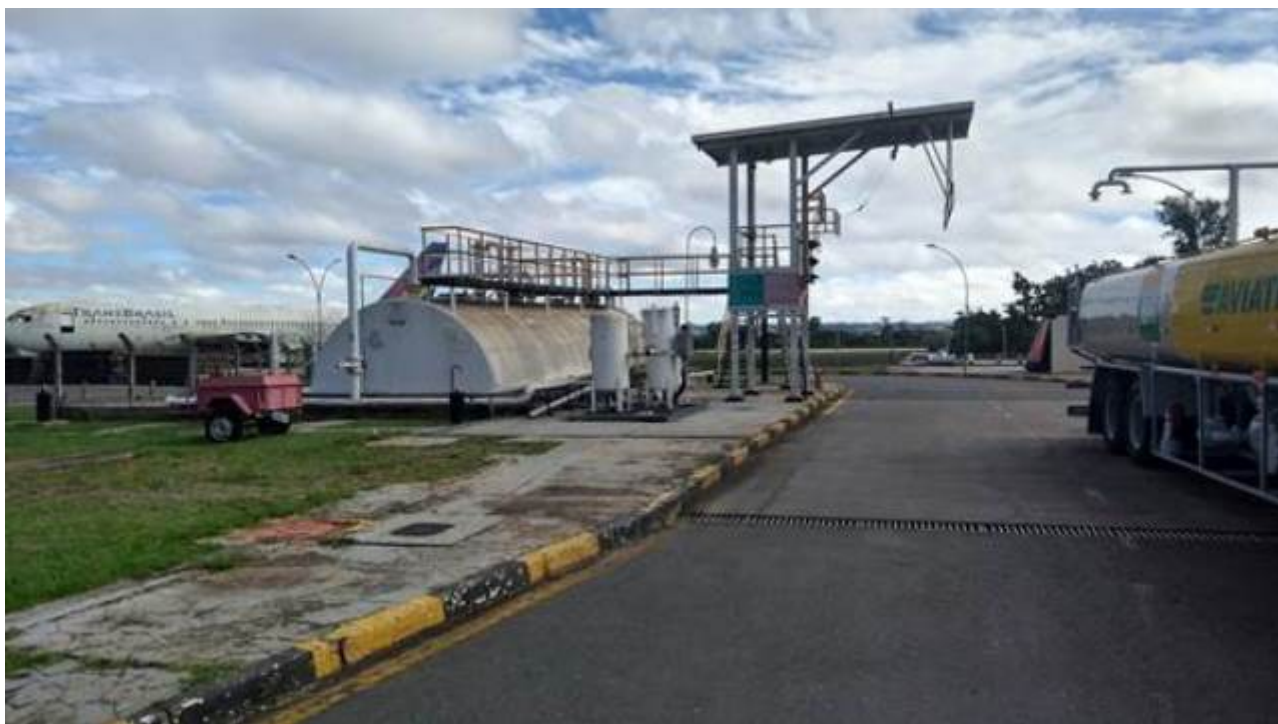
Foto 1 – Tanque semienterrado desativado e com previsão de remoção
