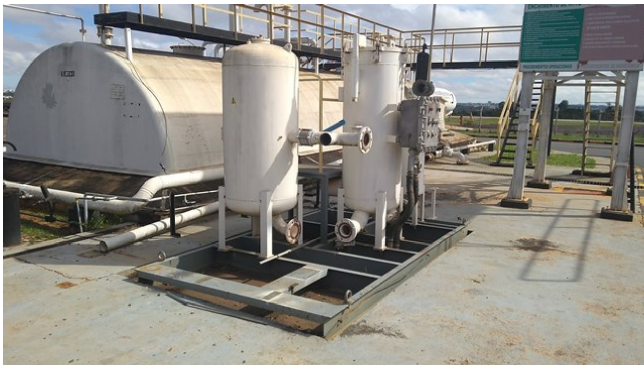
Foto 2 – Detalhe do tanque a ser removido e equipamentos associados, denotando desativação do mesmo
