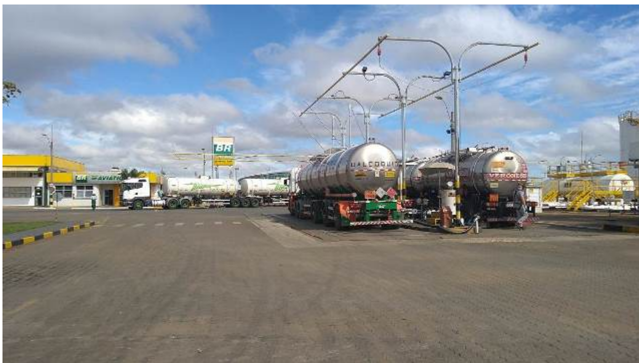
Foto 3 – Visão geral da área de recarga por caminhões tanque, que será reformada, retirando as posições de abastecimento ao fundo
