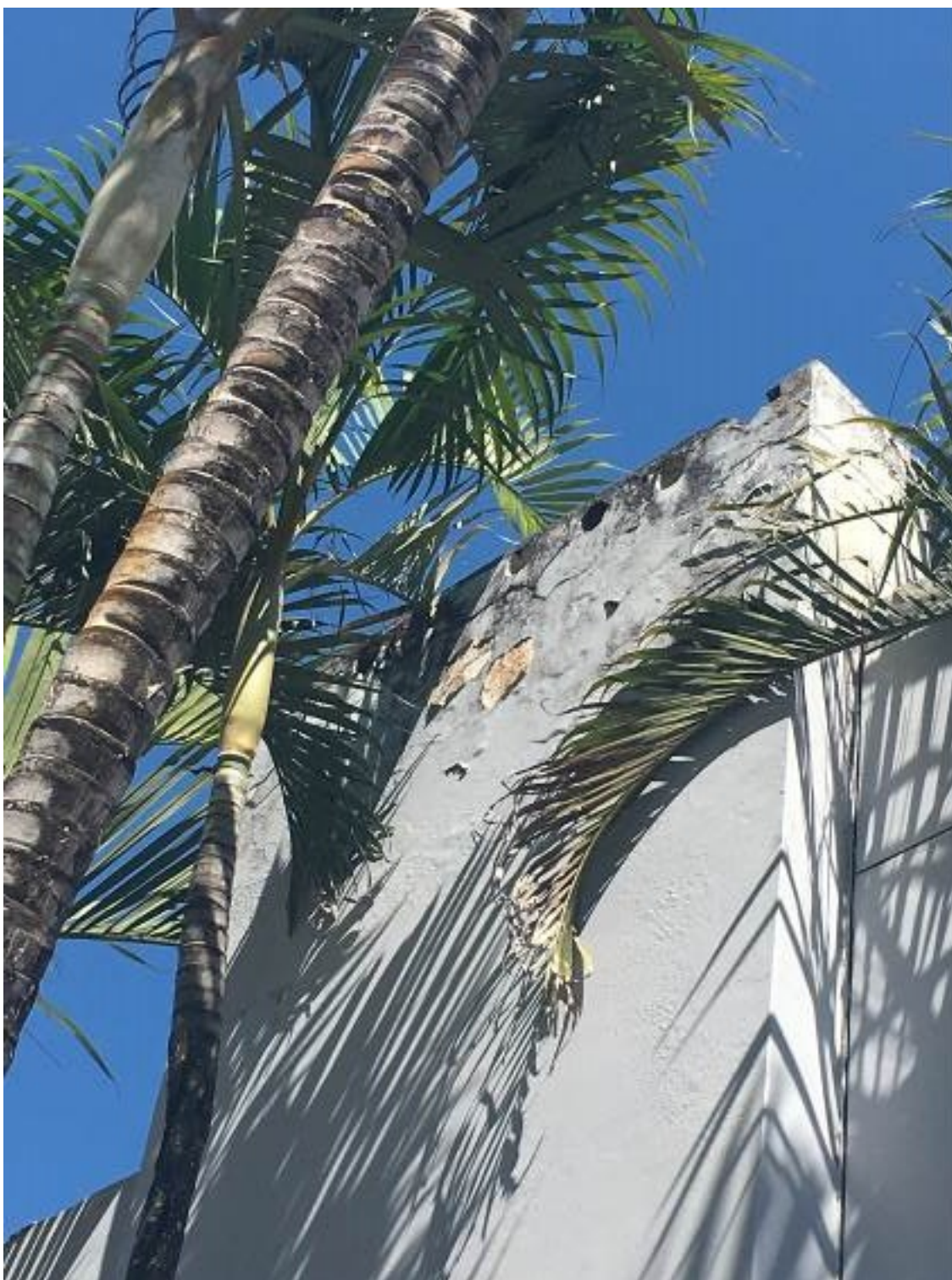
Figura 6 - Respiros dos tanques em desconformidade com a norma vigente.
