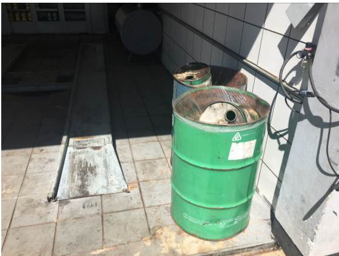
Figura 9 - Tanque aéreo de armazenamento de óleo usado e contaminado.
