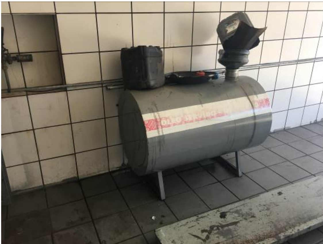
Figura 9 - Tanque aéreo de armazenamento de óleo usado e contaminado.
