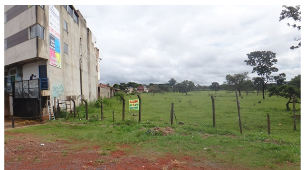
Foto 2 - Área proposta para as bacias de quantidade e qualidade às margens da DF-425. (margem diametralmente oposta à da Foto 1).
