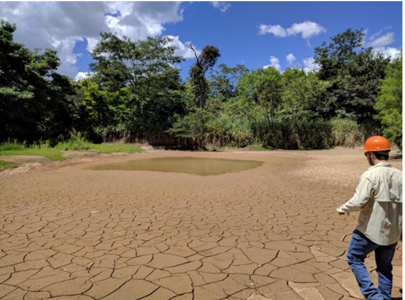
**Figura 3** - Interior da bacia de decantação do empreendimento. Apesar do acúmulo de argila não foram observados indícios de extravasamento e carreamento de sedimentos para além dos limites da área.
