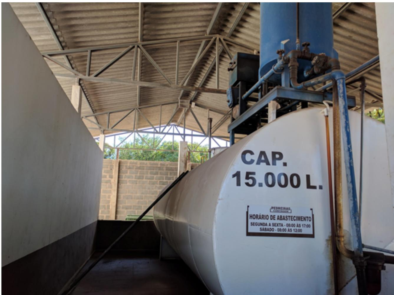
**Figura 6** - Tanque de armazenamento de diesel do ponto de abastecimento. No centro da imagem está o respiro do tanque, adequado de acordo com as normas técnicas.
