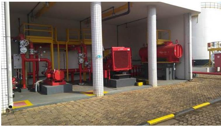
Foto 12 – Unidade de bombas da central de combate a incêndios
