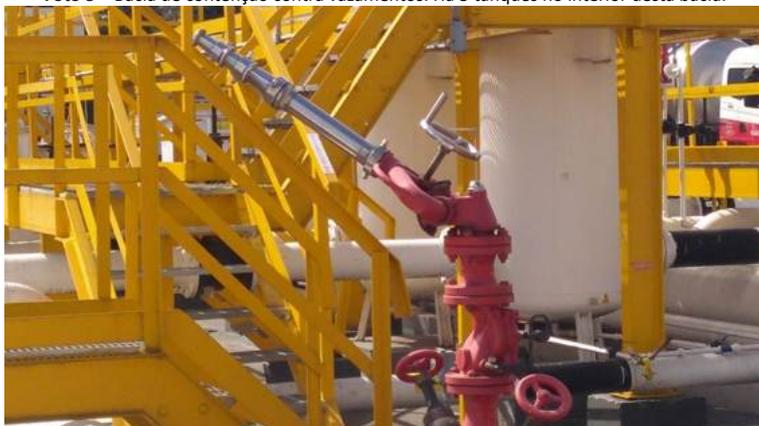
Foto 4 – Canhões d'água em volta da bacia onde estão contidos todos os tanques.
