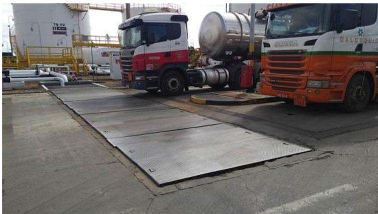
Foto 7 – Pista de abastecimento dos tanques dos caminhões com piso impermeável e canaletas direcionadas ao SAO.
