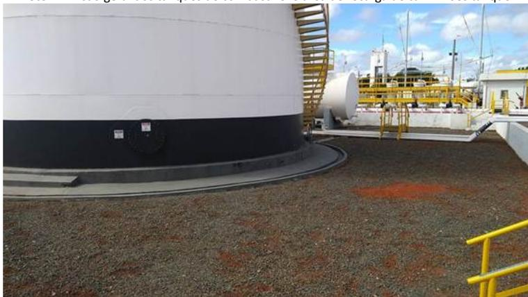
Foto 3 – Bacia de contenção contra vazamentos. Há 5 tanques no interior desta bacia.
