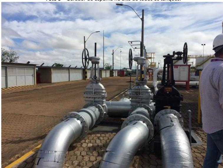
Foto 6 – Ponto de ligação entre o Pool e a rede de hidrantes de querosene do aeroporto de Brasília.
