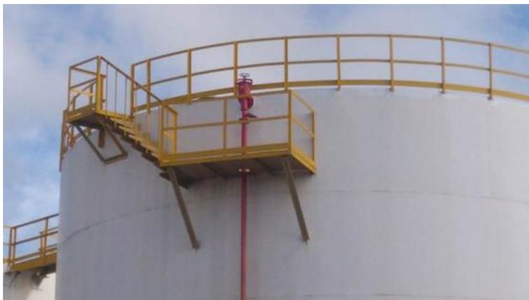
Foto 5 – Gerador de espuma no alto de todos os tanques.
