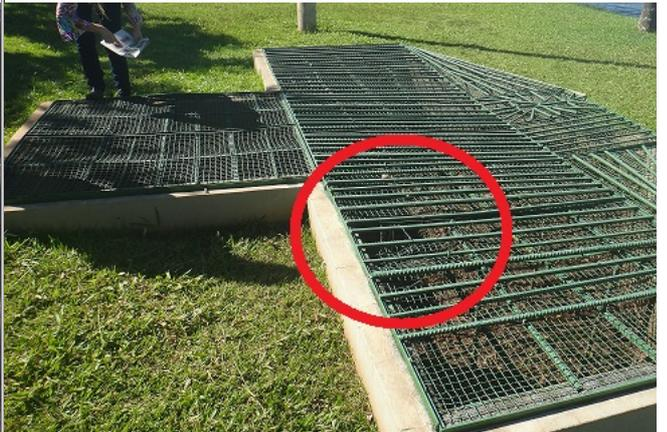
FOTO 7: Entrada do canal de drenagem com presença de vegetação.
