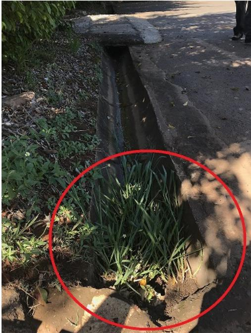
FOTO 8: Canal com acúmulo de sedimentos.
