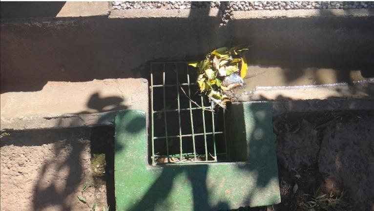
FOTO 6: Grade do dissipador avariada.
