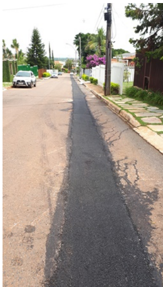
Foto 1 - Asfalto recuperado após instalação da rede.
