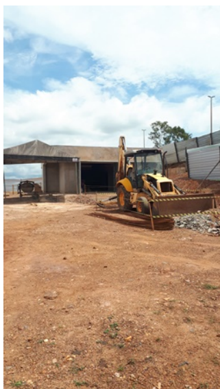
Foto 5 - Obra da elevatória EEE-2A.
