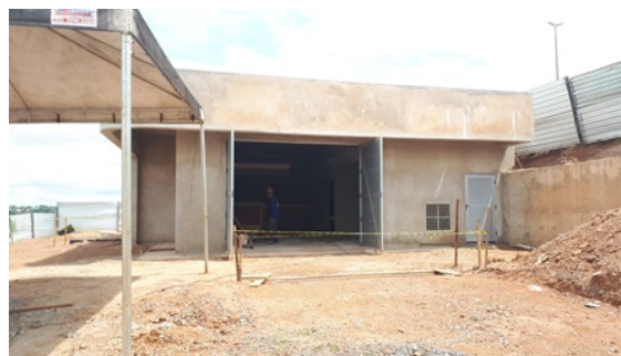
Foto 4 - Obra da elevatória EEE-2A.
