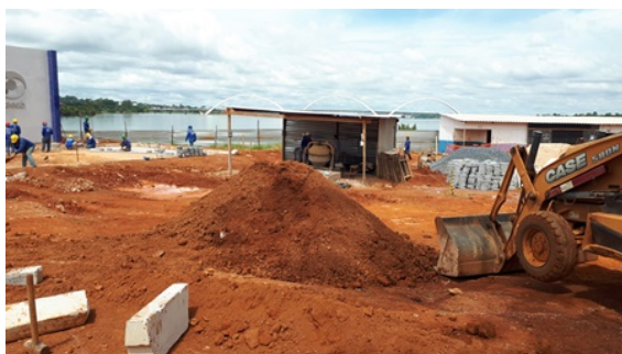
Foto 3 - Área cercada da obra da elevatória EEE-1A.
