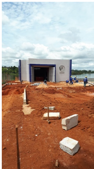
Foto 2 - Obra da elevatória EEE-1A.
