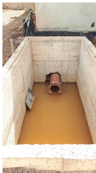
Foto 6 - Local de interligação da tubulação subaquática já instalada.
