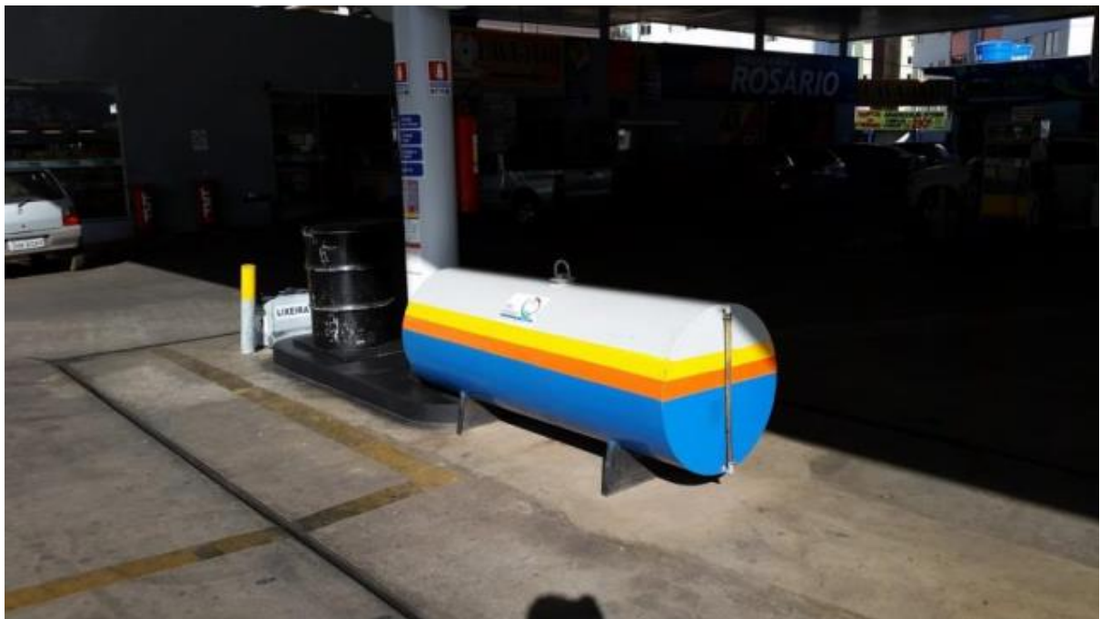
Figura 7 – Tanque de OLUK e barril onde são armazenadas embalagens de óleo usadas
