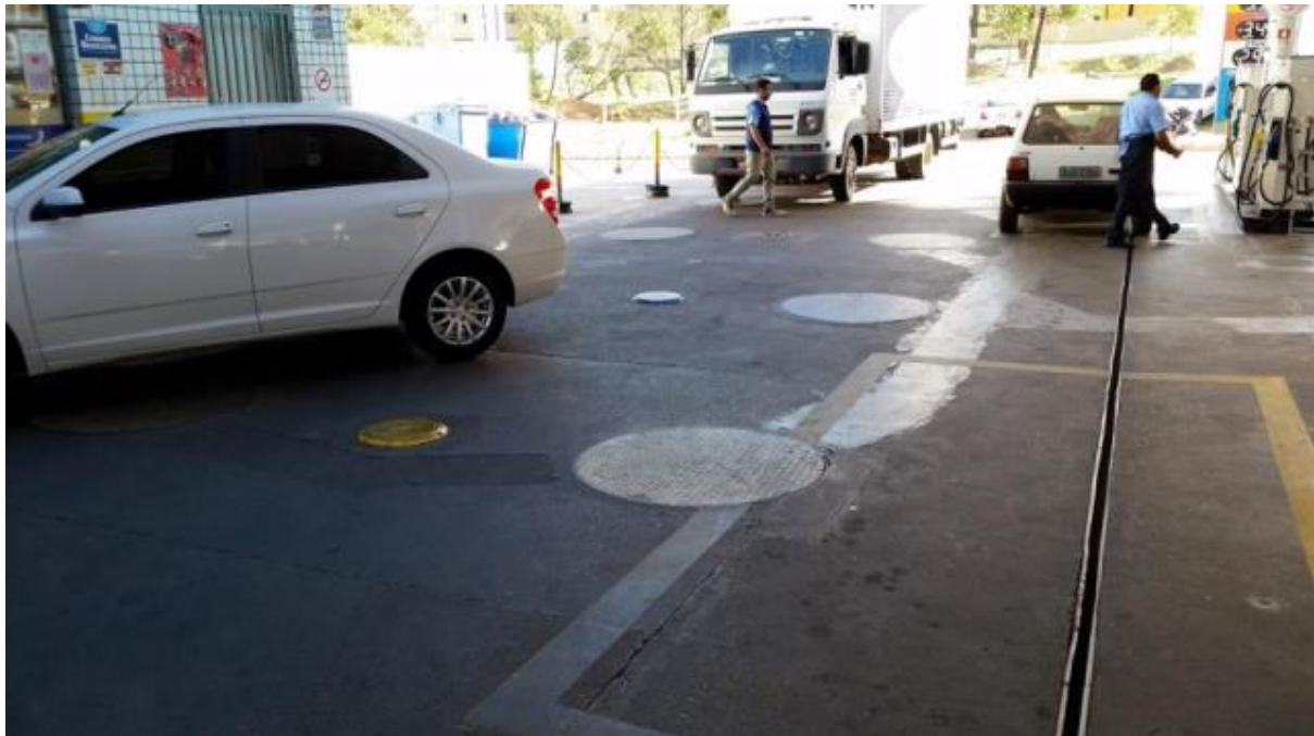
Figura 9 – Área dos tanques com piso impermeável e canaletes direcionados ao SAO
