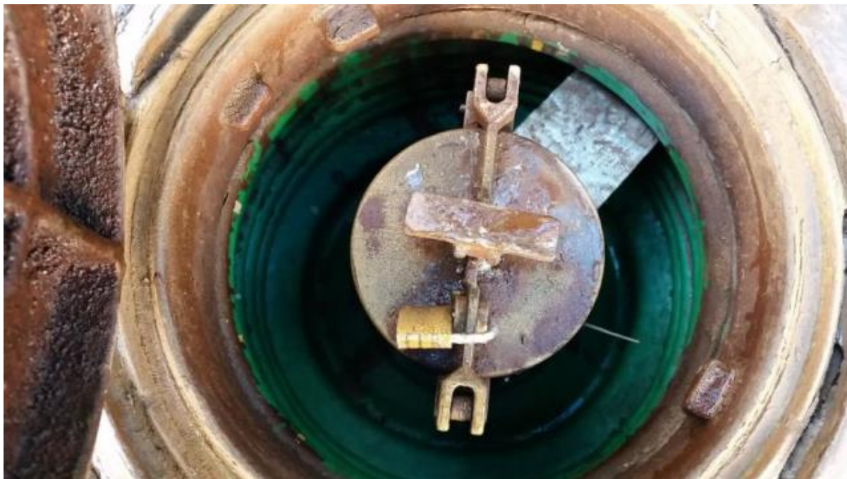
Figura 10 – Descarga Selada sobre o tanque equipada com câmara de contenção e válvula anti-transbordamento
