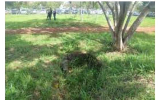
157. Manilha de águas pluviais sob a via da Gleba A, obstruída por vegetação.
