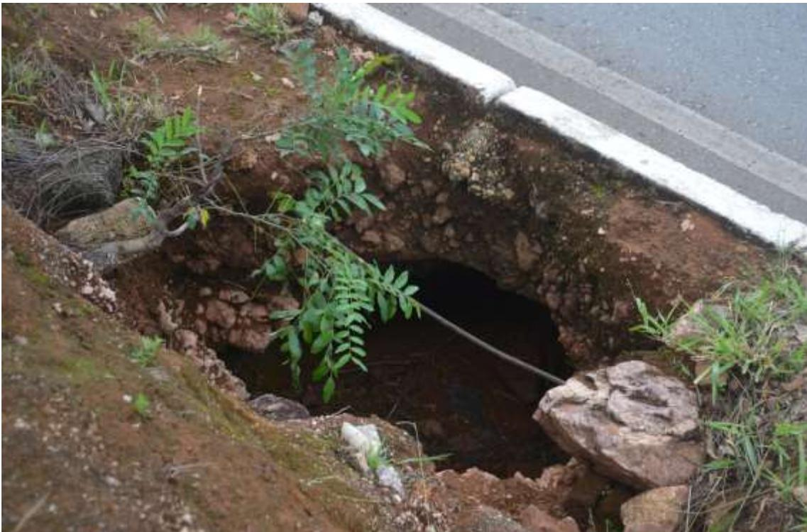
Foto 8: Erosão na base da via de ligação da Via L4 com a via da Ponte Honestino Guimarães, ao sudoeste da Gleba C do Parque Bosque dos Tribunais.
