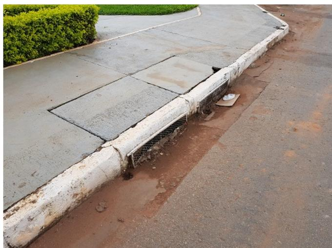
Figura 4: presença de sedimentos e resíduos sólidos na via.
