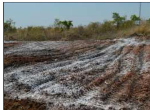
*Figura 6. Cal hidratada aplicada após a incorporação do lodo ao solo na cascalheira Rajadinha.*
