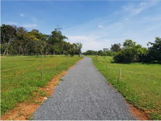
Figura Implantação de via de acesso com pavimentação de brita para caminhada;
