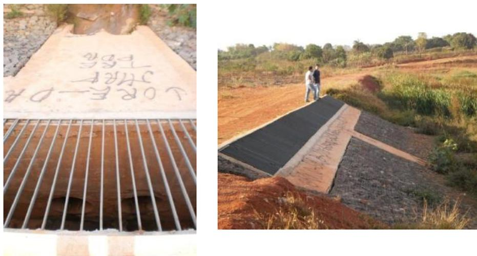
Figura 202 – Início do emissário que verte as águas coletadas nas bacias de contenção para o corpo receptor.
