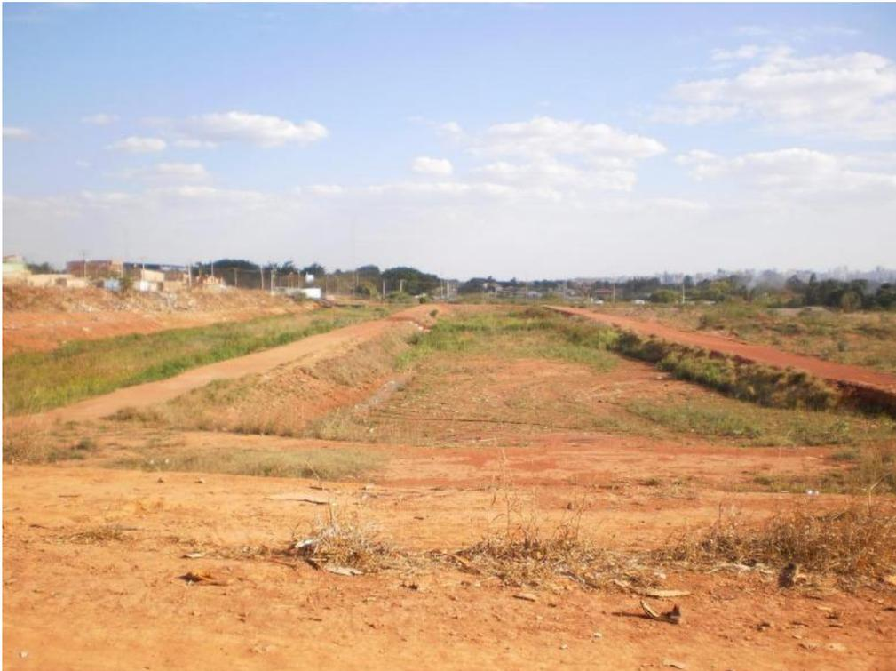
Figura 201 – Bacias de contenção de drenagem pluvial.
