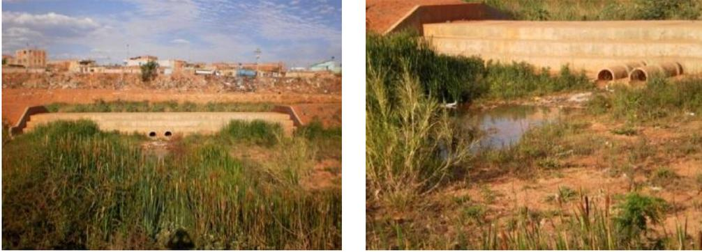
Figura 200– Dissipador e canal de ligação localizado no meio das bacias de contenção.
